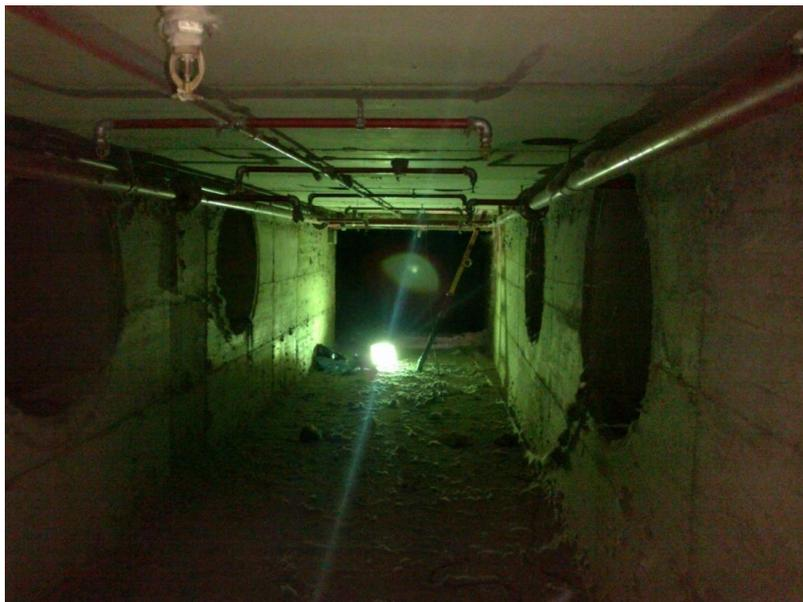
**Figura 2.4:** *Tunnel di convogliamento dell'aria aspirata dal reparto di tessitura di una azienda tessile del vercellese*
