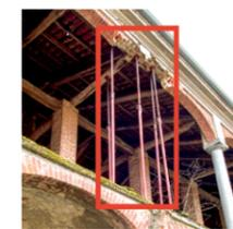
Puntellatura metallica inserita per sostenere la copertura in seguito alla rimozione della colonna portante in pietra.
