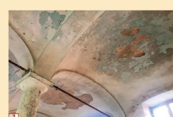
Le volte a vela a pianta rettangolare di diverse dimensioni hanno una tessitura in foglio (fig. 1), mentre in prossimità dell'imposta la disposizione dei mattoni pieni cambia e diventa di taglio (fig. 2).
