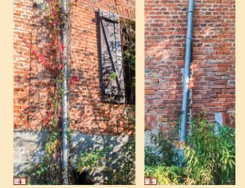
Sul prospetto principale ad ovest sono visibili le discontinuità murarie dovute alle trasformazioni storiche. La discontinuità tra il volume ante 1716 e il vano scala aggiunto nel 1716 - 1822 è riconoscibile grazie ad un leggero rilievo della muratura mentre l'altra discontinuità tra la muratura del blocco originale e quella del blocco realizzato successivamente è visibile grazie ad una diversa tessitura muraria nel punto di incontro tra le due murature.
