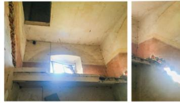
Nel vano scala si possono ancora vedere sui muri le tracce della volta a vela originale che è stata rimossa.
