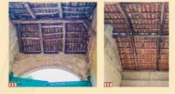
Tra le abitazioni realizzate sulle corti dell'ex tenuta agricola di Cavour, sono stati ripresi dei pontoni di passaggio, dove la copertura lignea è ben visibile. Essa è costituita da puntone in legno di sezione 20 x 25 cm (in alcuni dei quali sono ancorati delle controtraverse in legno che hanno la funzione di contenere la spinta dei puntone stessi, fig. 17), sostenuti dalla trave di colmo (30 x 25 cm).
