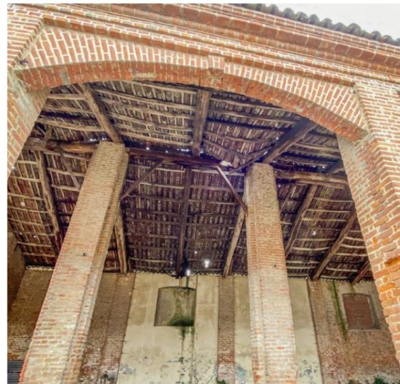
**20.** La tettoia che si differenzia dalle altre, per la presenza della sequenza di archi. Nella seconda foto, l'arco ribassato a estradosso piatto e la copertura lignea.
