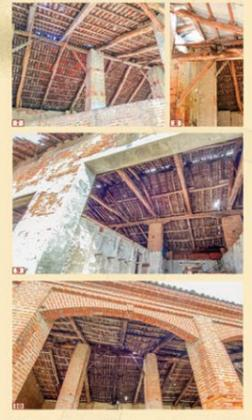
Nelle tenute, utilizzate probabilmente come depositi, sono state individuate due sistemi di copertura differenti: nel primo la trave di colmo (25 x 30 cm) su cui appoggiano i puntone (25 x 30 cm) è sorretta da pilastri murari, nel secondo è sorretta da capriate (travatura secondaria) e in entrambi i casi realizzata mediante travetti (10 x 12 cm) e listelli (5 x 8 cm).
