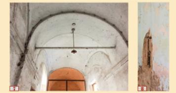
Sul prospetto ovest sono riconoscibili le sedi (ricavate per incasso) dei bolzoni dei capochiave relativi alle catene, inserite per migliorare l'ammorsamento della muratura. All'interno invece all'intradosso degli archi (nelle reni) sono visibili le catene metalliche di diametro circa 2 cm inserite per controllare la spinta delle volte.
