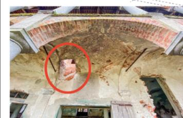
Campata del portico esterno in cui manca una porzione di volta a vela e si vede il minimo spessore dell'orizzontamento.
