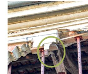
Ancoraggio emerso in seguito alla rottura del pilastro in laterizio.
