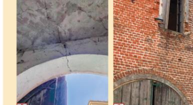
Nell'apertura d'ingresso al corpo di testata della scuderia, in corrispondenza della chiave dell'arco si è creata una fessurazione passante che si propaga sul prospetto, diventando in prossimità della finestra del piano primo una fessurazione non passante.
