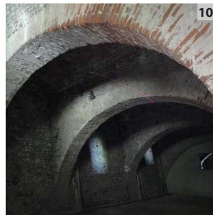
La sala presenta una pavimentazione in terra quasi battuta, ma per lo più dissestata. La muratura è mista e si possono chiaramente notare dei, forse, rimaneggiamenti al muro perimetrale, che dovrebbe addossarsi e sorreggere del terrapieno, e al muro di spina, con pietrame misto.
