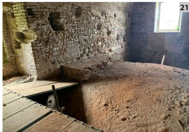
Locali al piano primo sprovvisti di solaio, con volta a vista e passerella in acciaio che permette la fruizione.
