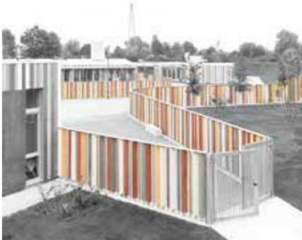
Pannelli rotanti posti in serie in facciata a costituire schermatura frangisole
