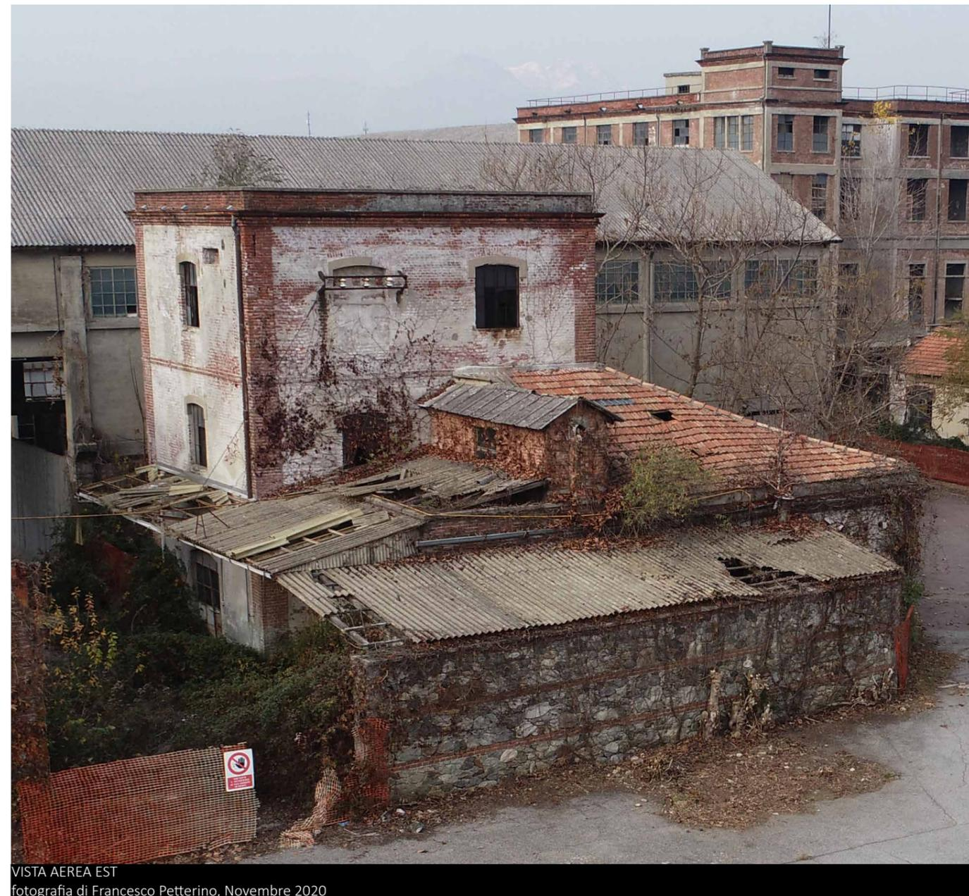
L'edificio Officina elettrica è un fabbricato, di impianto regolare che si sviluppa su un'area di m. 15x15; è costituito da due corpi, uno OVEST a 2 pft di altezza m. 10 con copertura piana e uno NORD EST a 1 pft con copertura a falda.
