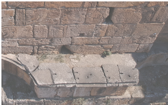
Fig. 2.30: Fori per il posizionamento delle colonne
