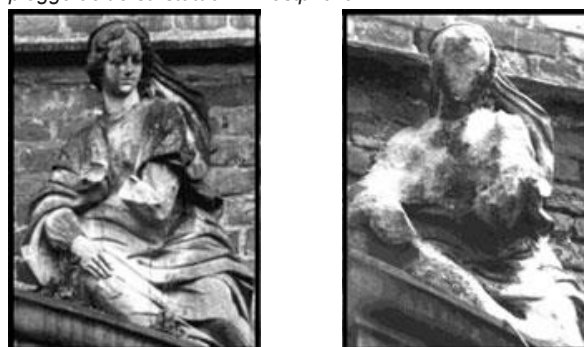
Fig. 1.1: Esempio di degrado causato dall’usura e dalle piogge acide su statua in Westphalia
