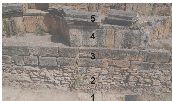
Fig. 2.26: Particolare della porzione inferiore della fronte est del Ninfeo del Santuario di Apollo
