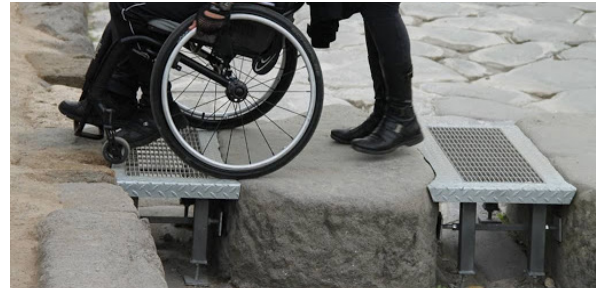
Fig. 1.4: Installazione dispositivi per disabili - Pompei
