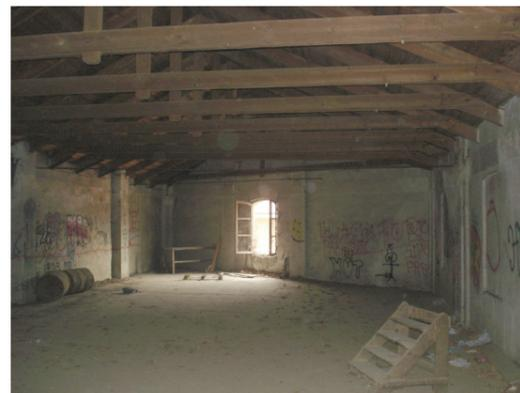
Fig. 21: Le capriate lignee a sostegno della copertura
