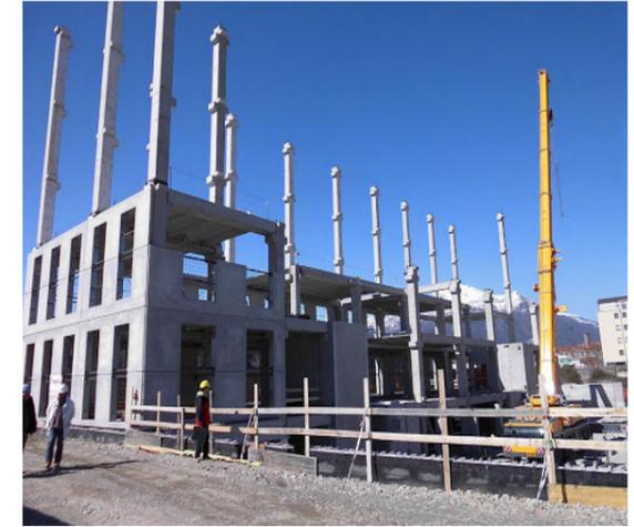
Figura 109 Fotografia della costruzione mediante sistemi prefabbricati
