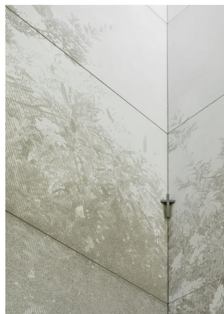
**18. Dettaglio della tecnica graphic concrete**
