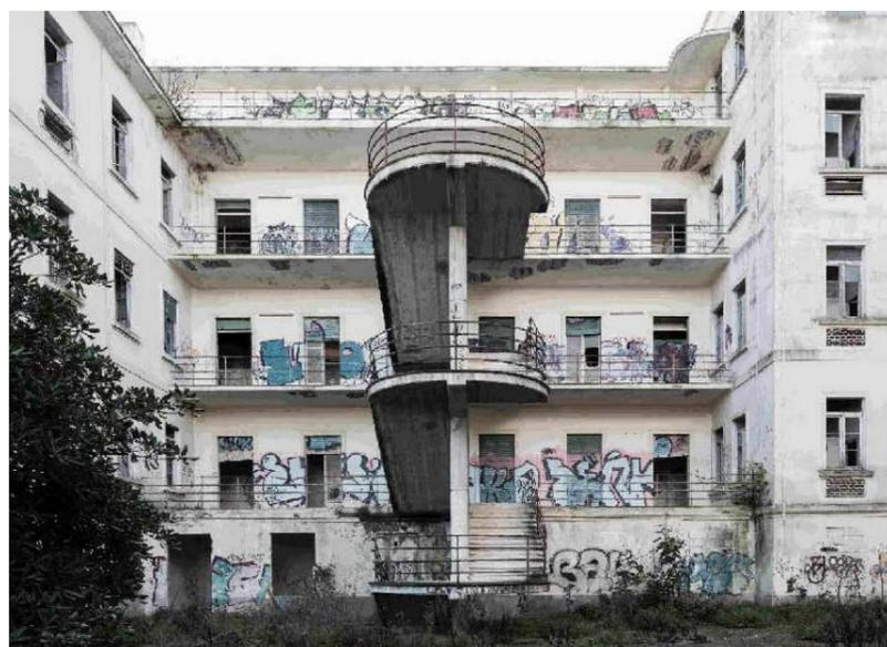
Img 50. Scale in cemento armato faccia a vista, inserite a seguito di un intervento di adeguamento alle normative di sicurezza antincendio.
