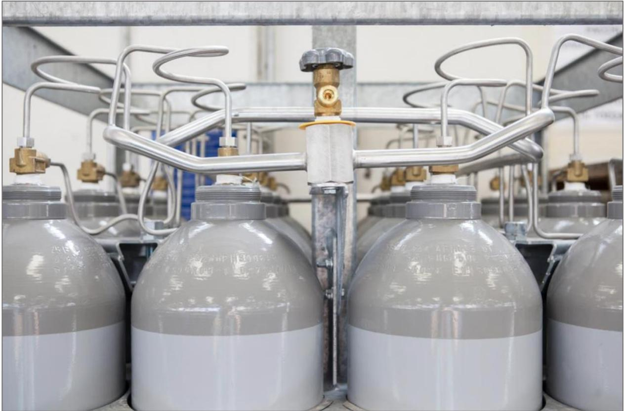
*Fig. 3.4 Pacco bombola costituito da 16 bombole connesse tra di loro, ad una unica uscita.*
