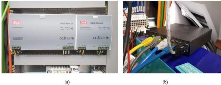
Figura 1.14: (a) Blocco alimentazione; (b) Switch
