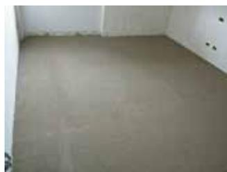
Sottofondo a secco in sabbia asciutta realizzato in piano sopra gli impianti tecnici.
