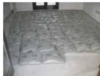
La copertura degli impianti tecnici viene eseguita dall'impresa edile prima dell'intonacatura dei muri perimetrali.
