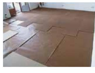
Per abitazioni al piano terra e consigliato realizzare un isolamento termico mediante la posa di un pannello in fibra di legno o sughero.
