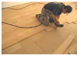
Il parquet in legno massello maschiato viene direttamente inchiodato al sottopavimento in fibra dura di legno.
