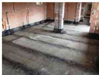
Ulteriore barriera all'umidità mediante l'asfaltatura di una guaina bituminosa risvoltata sui muri perimetrali fino all'altezza del pavimento finito.
