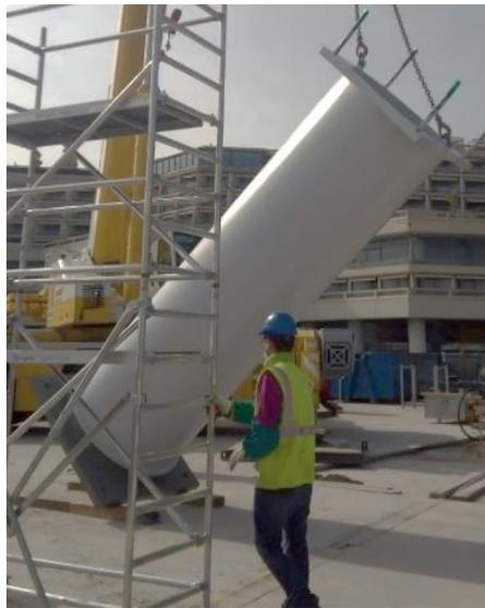
Figura 1-7 Elemento caso studio (colonna in acciaio con lastre agli stremi)
