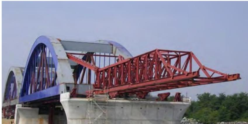
**Figura 5-6 Avambecco a becco di anatra, (STUDIO DEL VARO DI UN IMPALCATO A GEOMETRIA, Vanny Ceotto)**
