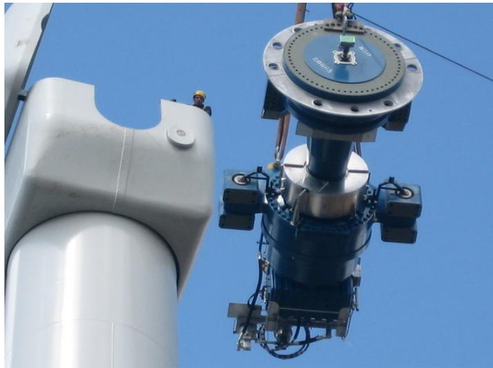
**Figura 2.7** Organi di trasmissione (albero, cambio e freno) di una turbina eolica. (Di Paul Anderson, CC BY-SA 2.0, <https://commons.wikimedia.org/w/index.php?curid=5125761>)
