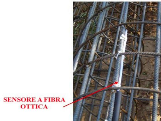
**Figura 3.29** Installazione di un sensore su un palo
