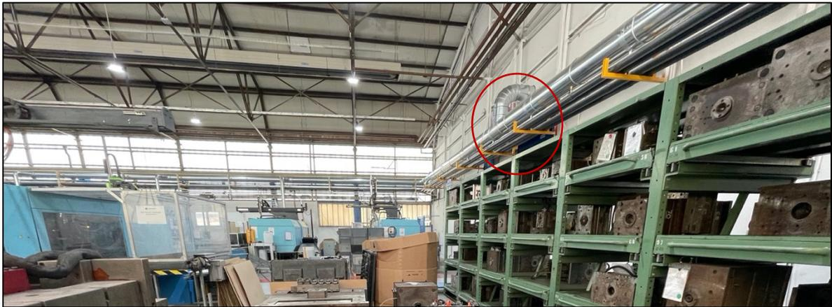
Figura 5.10: Collettore impianto aspirazione fumi
