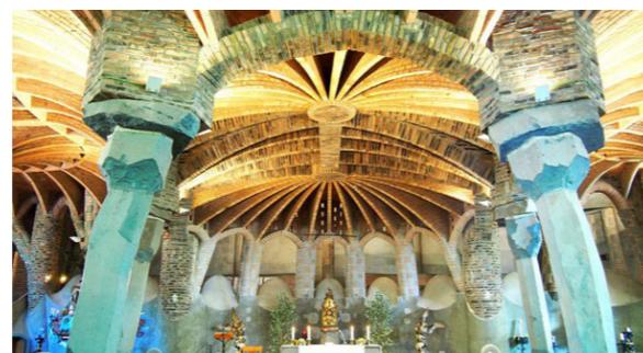
Cripta della cappella della colonia Güell. Si notano le colonne e le paraboloidi iperboliche, che sono infinitamente variabili parametricamente.
