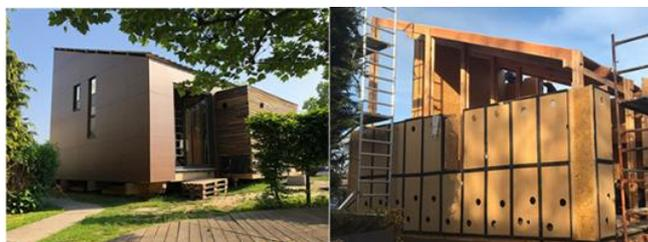
Figura 1.9. Build reversible in conception (BRIC), costruzione sostenibile, scalabile, smontabile e reversibile, EFP, 2018. Costruzione in legno con materiali di recupero.
