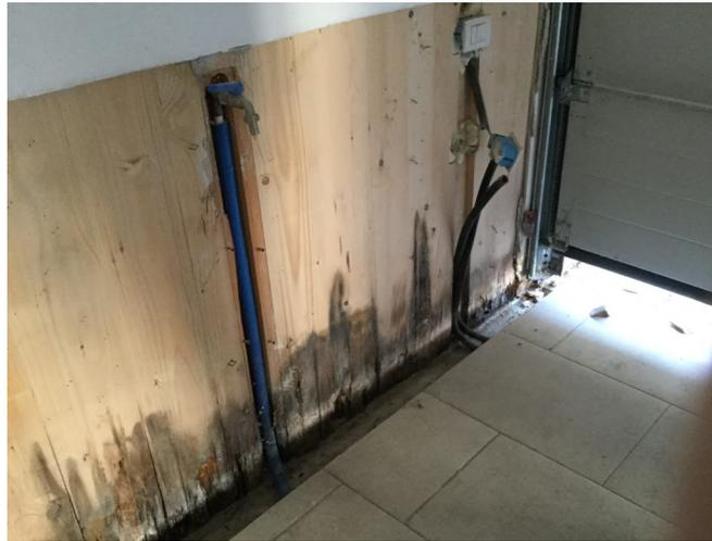
**Figura 4.94** Parete in X-Lam fresata per il passaggio degli impianti. Fonte: anonima
