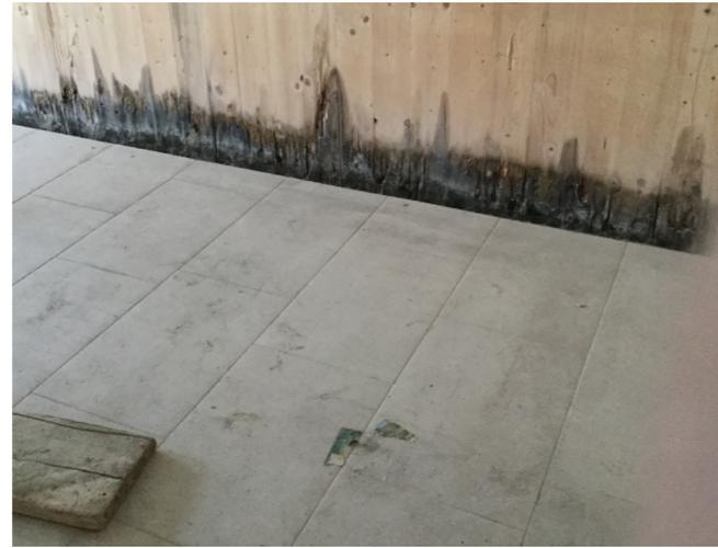
**Figura 4.90** Attacco a terra: si può notare la mancanza di un cordolo, di una guaina di protezione, la possibile presenza di una griglia e l'assenza delle connessioni. Fonte: anonima
