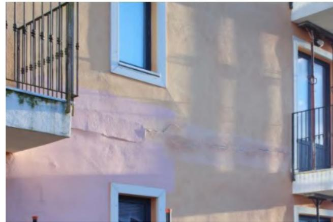
**Figura 4.51** Fotografia del tentativo di nascondere una lesione che percorre orizzontalmente la facciata da balcone a balcone. Fonte: [www.abruzzoweb.it](http://www.abruzzoweb.it)
