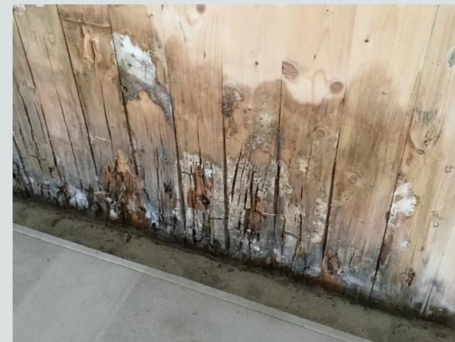
**Figura 3.7** Problema di umidità di risalita presente nell'attacco a terra di un edificio. Fonte: *anonimo*
