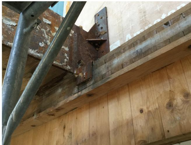
**Figura 4.101** Si può notare la piastra di fissaggio del pannello in X-Lam del balcone
