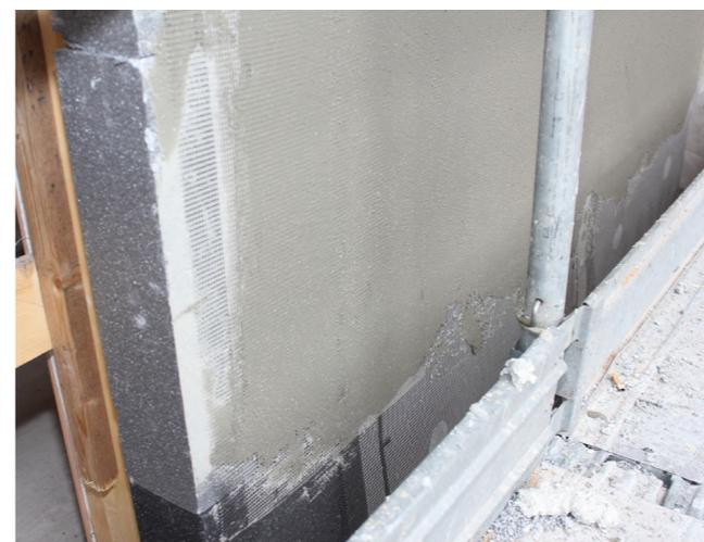
**Figura 4.16** Rasatura e finitura dei pannelli in EPS. Fonte: Bernasconi A. (a cura di), *Materiale didattico del seminario "Wood groving city. Il contributo del legno per una crescita urbana sostenibile" del 24 Maggio 2013 con il titolo "Legno in città. Via Cenni: 9 piani in legno a Milano"*, Milano, scaricato da [www.promolegno.it](http://www.promolegno.it)
