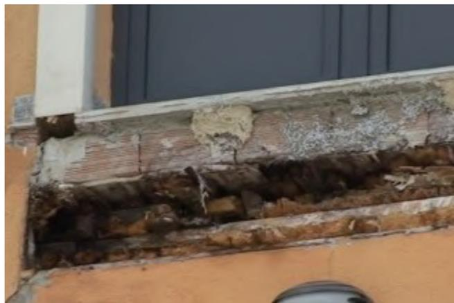
**Figura 4.46** Fotografia della parete scattata a seguito del crollo del balcone. Fonte: [www.abruzzo24ore.tv](http://www.abruzzo24ore.tv)
