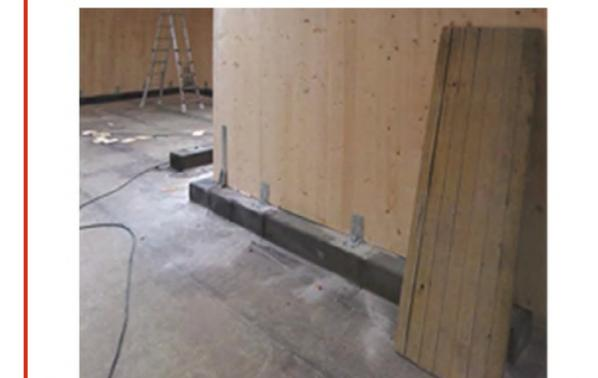
Fig. 5.5 – Attacco a terra eseguito correttamente, la guaina bituminosa protegge il CLT dalla risalita dell'umidità per capillarità.
