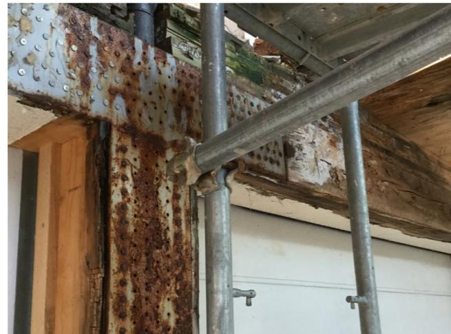
**Figura 4.97** Elevato grado di corrosione della piastra a T. Fonte: anonima
