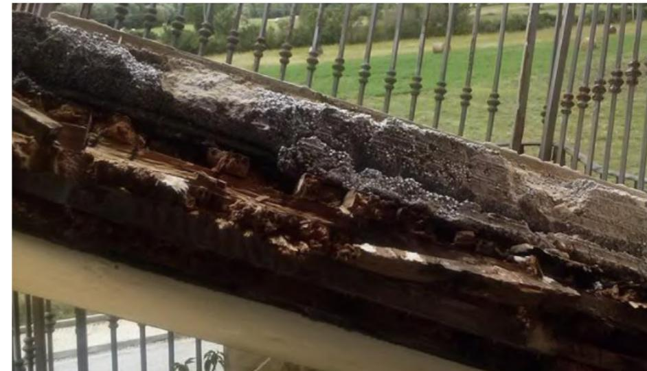
**Figura 4.45** Fotografia del primo balcone crollato in cui è possibile vedere il legno marcito e la muffa all'interno del cemento. Fonte: [www.6aprile.it](http://www.6aprile.it)
