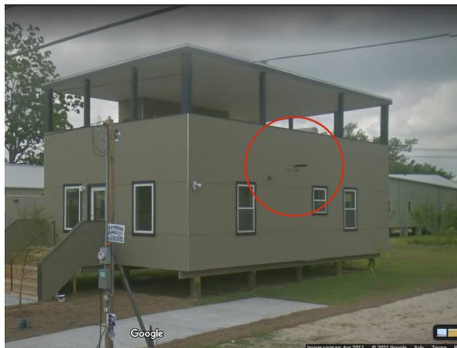
**Figura 4.67** Fotografia dell'edificio aprile 2011: si nota la tubazione di scarico del terrazzo che è sporgente rispetto al filo dell'edificio. Fonte: [Google Maps](https://www.google.com/maps)
