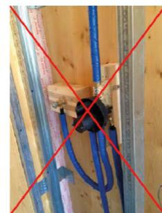
Figura 2.8 Assenza di protezione per la struttura in legno.
