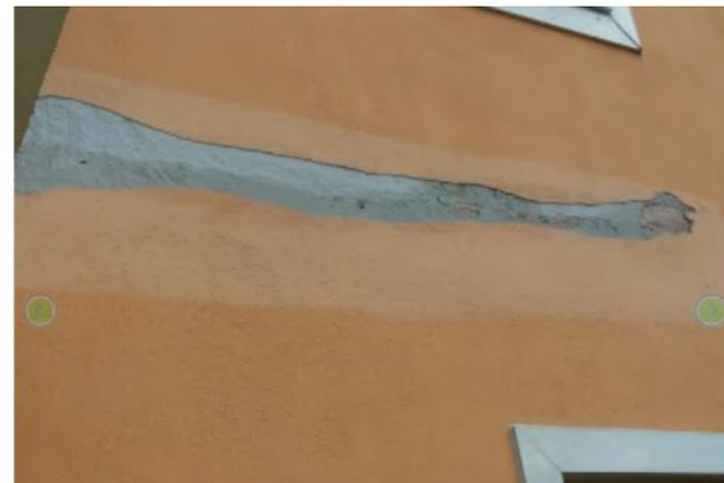
**Figura 4.53** Fotografia di una lesione che è riaffiorata nonostante il tentativo di nascondere con una mano di vernice di colorazione differente. Fonte: [www.abruzzoweb.it](http://www.abruzzoweb.it)
