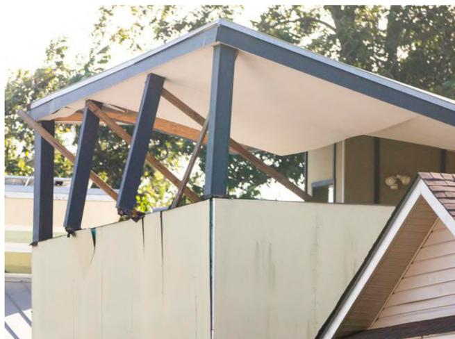
**Figura 4.69** Fotografia dell'edificio in cui si può notare che non è presente una scossalina di protezione delle pareti ma sembra essere stato utilizzato una sorta di telo. Fonte: [www.nola.com](http://www.nola.com)
