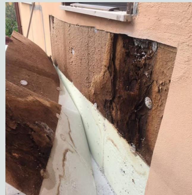
**Figura 3.12** Marcescenza dell'isolante di un edificio in legno. Fonte: anonima
