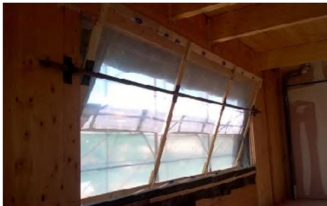
**Figura 4.41** Infissi provvisori realizzati per proteggere le strutture durante il cantiere. Fonte: Ufficio Tecnico Assolegno e ANTIAL (a cura di), 2019, *Appunti per le costruzioni in legno. Concezione, Normativa, progettazione e buone pratiche di cantiere*, documento fornito da Marco Pio Lauriola
