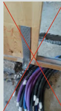
**Figura 4.107** Passaggio errato degli impianti con scasso del cordolo e assenza di appoggio per l'hold-down. Fonte: “Ufficio Tecnico Assolegno e ANTIAL (a cura di), 2019, Appunti per le costruzioni in legno. Concezione, Normativa, progettazione e buone pratiche di cantiere, documento fornito da Marco Pio Lauriola”, pg. 137
