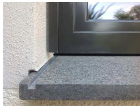
**Figura 4.24** La fresatura sul bancale in pietra che favorisce il deflusso delle acque verso l'esterno. Fonte: Ufficio Tecnico Assolegno e ANTIAL (a cura di), 2019, *Appunti per le costruzioni in legno*. Concezione, Normativa, progettazione e buone pratiche di cantiere, documento fornito da Marco Pio Lauriola, pg. 94
