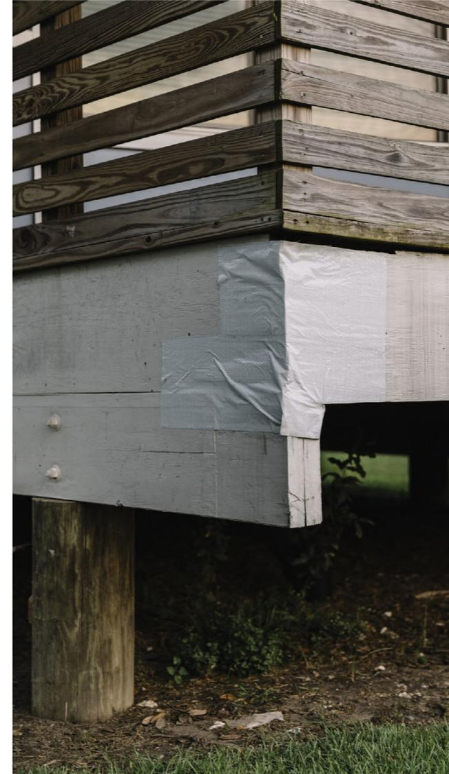
**Figura 4.87** Mancanza di cura e progettazione per il dettaglio. Fonte: [www.nbcnews.com](http://www.nbcnews.com) foto di Williams Widmer
