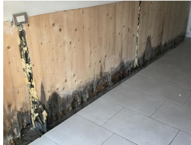
**Figura 4.95** Parete in X-Lam fresata per il passaggio degli impianti e utilizzo di schiume per il fissaggio dei tubi. Fonte: anonima
