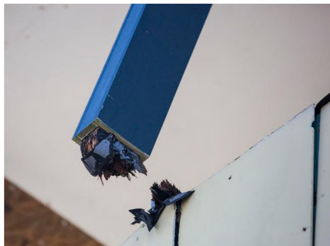
**Figura 4.70** Fotografia del distacco di un pilastro che reggeva la struttura del tetto. Fonte: [www.nola.com](http://www.nola.com) Foto di Sophia Germer
