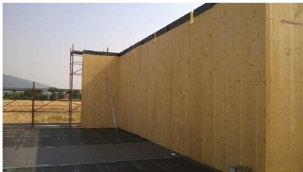
Fig. 6.8 – Protezione delle teste delle pareti con guaine traspiranti durante il cantiere
