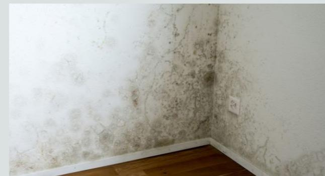
**Figura 3.13** Problemi di umidità da condensa. Fonte: <https://www.ediltecnico.it/67364/umi-dita-condensa-o-infiltrazioni-acqua/>
