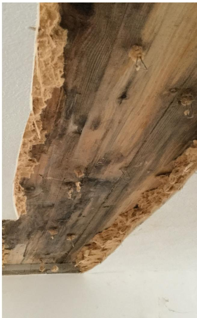
**Figura 4.102** Pannello del solaio impregnato di acqua in seguito allo sversamento di 190 l di acqua . Fonte: *anonima*
