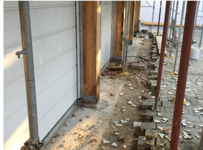
**Figura 4.92** Attacco a terra: si può notare come i pilastri in legno siano posati direttamente a terra e si trovino al di sotto del piano di calpestio senza protezioni (guaine, bicchiere..). Fonte: anonima
