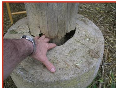
Figura 4.2: Questo è sicuramente il modo peggiore per realizzare l'appoggio a terra di un pilastro. In queste condizioni si forma un vero e proprio bicchiere che trattiene l'umidità e qualunque specie legnosa subisce degrado da funghi della carie in un tempo più o meno breve.
