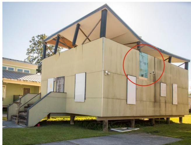
**Figura 4.68** Fotografia pre-demolizione in cui si può notare che la tubazione di scolo del terrazzo è stata tranciata ed è a filo parete. Fonte: [www.nola.com](http://www.nola.com)
