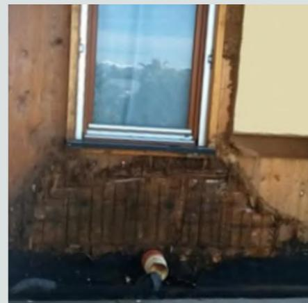
**Figura 3.10** L’errore di installazione del davanzale ha portato a un evidente degrado. Fonte: Lauriola M. P., presentazione del 16.03.2021 al seminario: edilizia in legno: le regole del buon costruire, ente Maggioli Spa in collaborazione con Federlegno Arredo e THE PLAN
