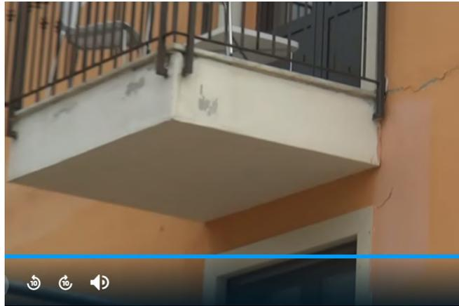
**Figura 4.50** Fotografia in cui si può notare una lesione orizzontale in corrispondenza del nodo balcone-parete. La lesione verticale invece è stata nascosta da una mano di vernice di colorazione differente. Fonte: [www.raipaly.it](http://www.raipaly.it), trasmissione gazebo ottobre 2014
