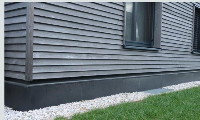
**Figura 4.138** Fotografia di un corretto posizionamento del rivestimento rialzato da terra. Fonte: Koch C., 2021, Materiale didattico "Holzschutz: Fassaden. Dos and don'ts" del seminario "Modul I Konstruktion/Bemessung/Holzschutz" organizzato da ProHolz il 19 Maggio 2021, scaricato da [www.proholz.at](http://www.proholz.at), pg.43
