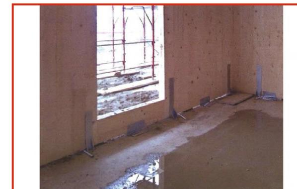
Fig. 5.4 – Attacco a terra non corretto; la parete in CLT è stata posata direttamente sulla platea senza una guaina di separazione.
