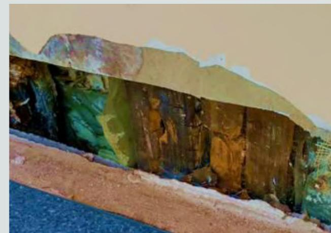
**Figura 3.8** Danneggiamento di una parete in legno dovuto alla risalita capillare. Fonte: <https://www.ingenio-web.it/23894-soluzione-innovativa-per-prevenire-il-deterioramento-delle-pareti-in-legno-allattacco-con-la-fondazione>
