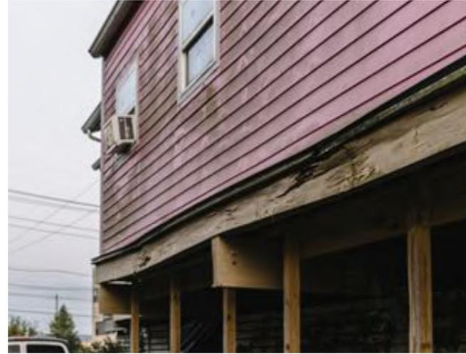
**Figura 4.84** Progettazione assente in funzione delle 4D: mancanza di drenaggio. Fonte: [www.nbcnews.com](http://www.nbcnews.com) foto di Williams Widmer
