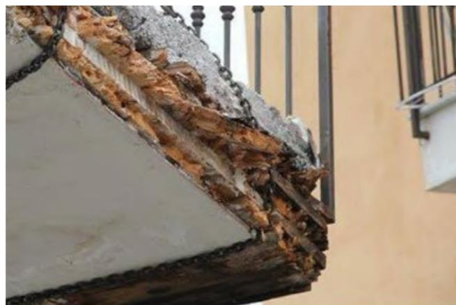
**Figura 4.49** Fotografia laterale del balcone crollato. Fonte: [www.6aprile.it](http://www.6aprile.it)
