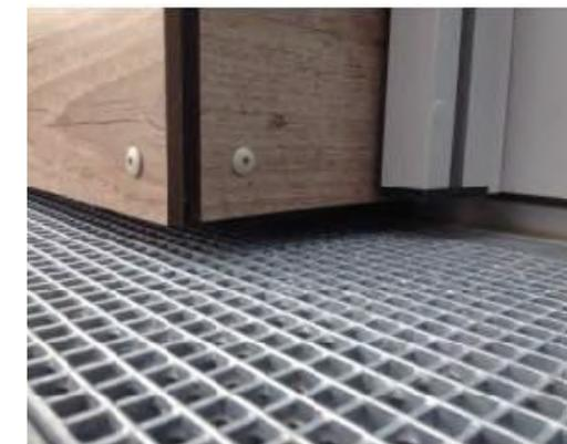
**Figura 4.63** Esempio posa di un grigliato lungo il perimetro esterno di un edificio. Fonte: Ufficio Tecnico Assolegno e ANTIAL (a cura di), 2019, *Appunti per le costruzioni in legno. Concezione, Normativa, progettazione e buone pratiche di cantiere*, documento fornito da Marco Pio Lauriola, pg.79
