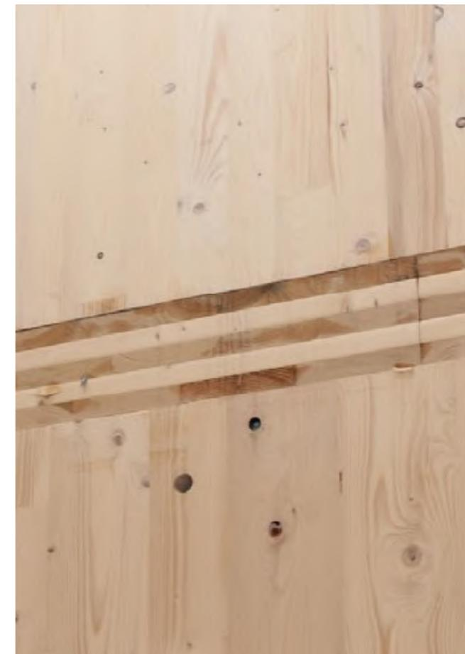
**Figura 4.10** Fotografia di cantiere: si possono notare macchie dovute all'infiltrazione di acqua. Fonte: *Bernasconi A. (a cura di), Materiale didattico del seminario "Wood groving city. Il contributo del legno per una crescita urbana sostenibile" del 24 Maggio 2013 con il titolo "Legno in città. Via Cenni: 9 piani in legno a Milano", Milano, scaricato da [www.promolegno.it](http://www.promolegno.it)*
