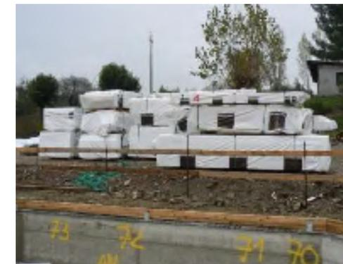
**Figura 4.38** Corretto stoccaggio in cantiere del materiale. Fonte: Ufficio Tecnico Assolegno e ANTIAL (a cura di), 2019, *Appunti per le costruzioni in legno. Concezione, Normativa, progettazione e buone pratiche di cantiere*, documento fornito da Marco Pio Lauriola
