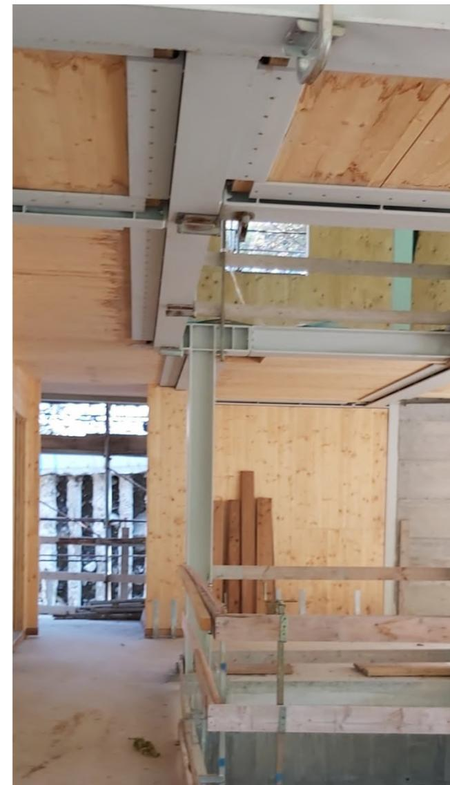
Figura 4.35 Solai macchiati, foto di cantiere. Fonte: *Anonima*
