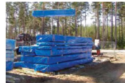
**Figura 4.39** Corretto stoccaggio in cantiere del materiale. Fonte: Ufficio Tecnico Assolegno e ANTIAL (a cura di), 2019, *Appunti per le costruzioni in legno. Concezione, Normativa, progettazione e buone pratiche di cantiere*, documento fornito da Marco Pio Lauriola
