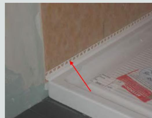
**Figura 4.111** Profilo rompigoce della doccia. Fonte: Fedelegnoarredo, Manuale d'uso e manutenzione, guida fornita dall'Ingegnere Matteo Izzi, ufficio tecnico Assolegno, pg.25
