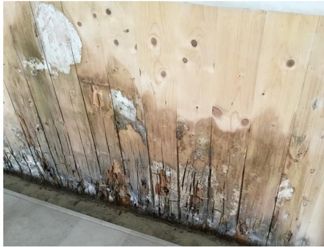
**Figura 4.89** Attacco a terra: si può notare la mancanza di un cordolo, di una guaina di protezione, la possibile presenza di una griglia e l'assenza delle connessioni. Fonte: anonima
