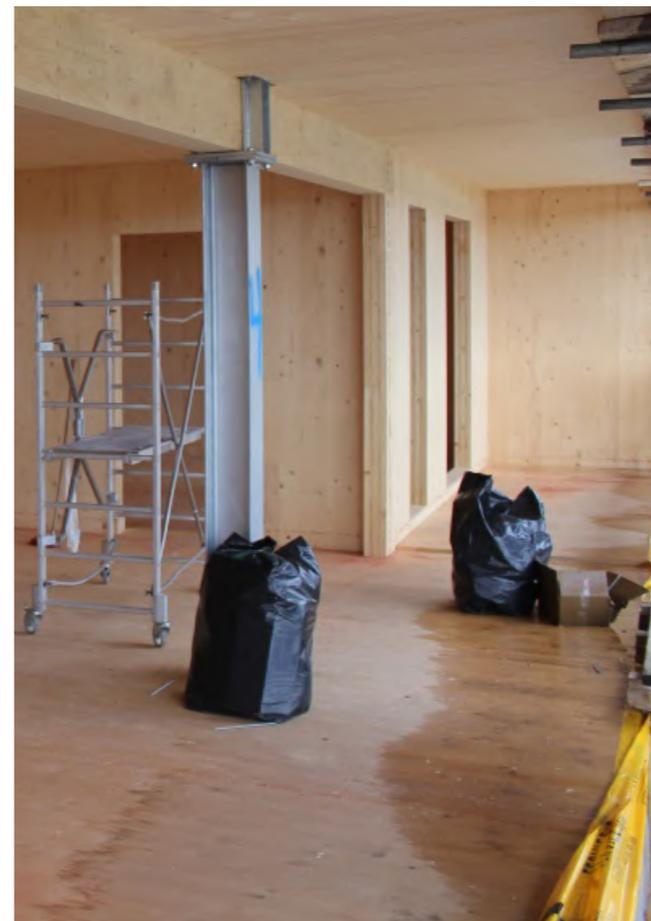
**Figura 4.9** Fotografia di cantiere: si possono notare macchie dovute all'infiltrazione di acqua. Fonte: *Bernasconi A. (a cura di), Materiale didattico del seminario "Wood groving city. Il contributo del legno per una crescita urbana sostenibile" del 24 Maggio 2013 con il titolo "Legno in città. Via Cenni: 9 piani in legno a Milano", Milano, scaricato da [www.promolegno.it](http://www.promolegno.it)*
