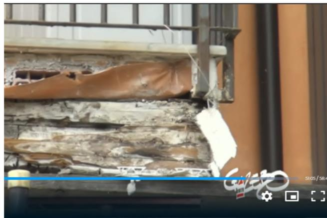
**Figura 4.47** Fotografia balcone: struttura in X-Lam, getto e mattoni. Fonte: [www.raiply.it](http://www.raiply.it), trasmissione gazebo ottobre 2014
