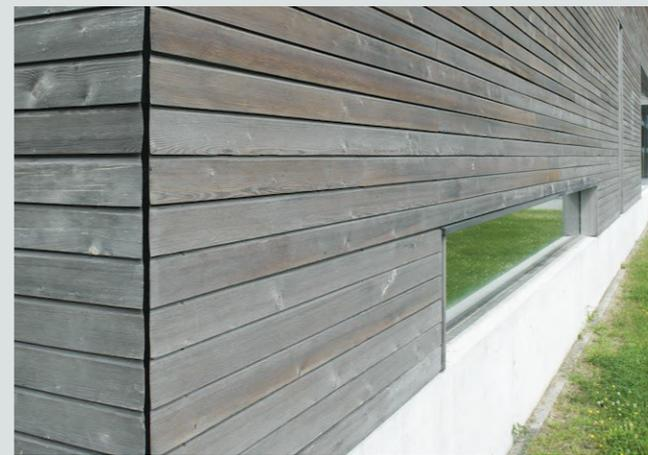
**Figura 4.133** Fotografia di una facciata che ha subito una verniciatura detta di "pre-ingrigimento". Fonte: Proholz, foto: Günter Wett
