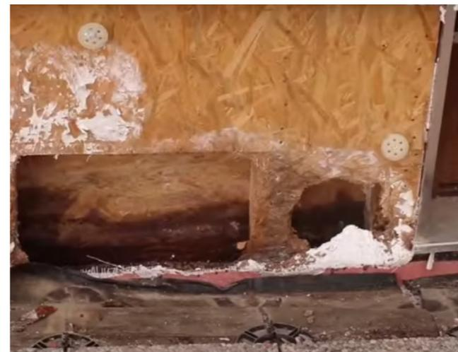
**Figura 4.60** Fotografia della marcescenza presente nell'attacco a terra: si può notare che la guaina impermeabilizzante viene fatta risvoltare di pochi centimetri davanti all'intonaco della parete finita. Fonte: [www.fanpage.it](http://www.fanpage.it)
