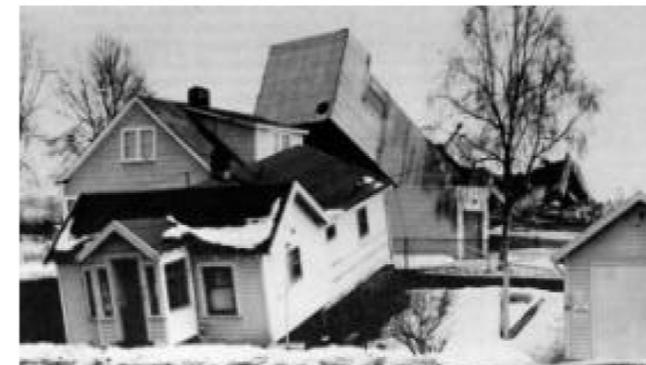
**Figura 3.23** Blocco ascensore di un edificio in calcestruzzo armato crollato a seguito del terremoto di Anchorage, Alaska del 1964 (magnitudo 8,4), accanto a una casa a struttura di legno rimasta intatta. Fonte: <https://www.totaldesign.it/>
