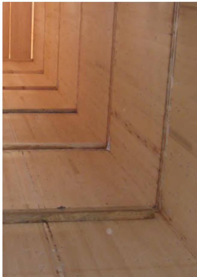
**Figura 4.8** Fotografia di cantiere: vano scala: si possono notare macchie dovute all'infiltrazione di acqua. Fonte: *Bernasconi A. (a cura di), Materiale didattico del seminario "Wood groving city. Il contributo del legno per una crescita urbana sostenibile" del 24 Maggio 2013 con il titolo "Legno in città. Via Cenni: 9 piani in legno a Milano", Milano, scaricato da [www.promolegno.it](http://www.promolegno.it)*
