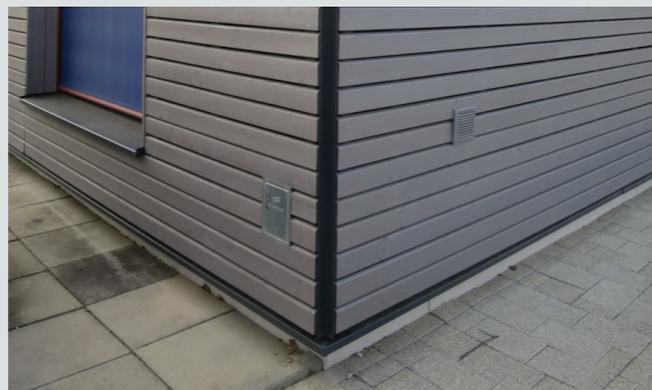
**Figura 4.136** Fotografia di una facciata con il giunto ad angolo di protezione. Fonte: Koch C., 2021, Materiale didattico "Holzschutz: Fassaden. Dos and don'ts" del seminario "Modul I Konstruktion/Bemessung/Holzschutz" organizzato da ProHolz il 19 Maggio 2021, scaricato da [www.proholz.at](http://www.proholz.at), pg.67
