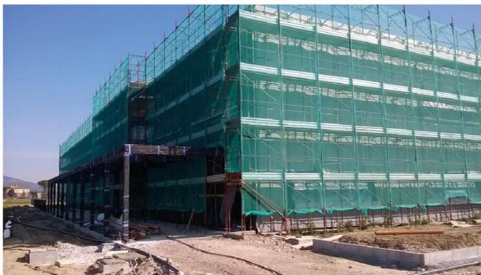
Fig. 6.9 – Protezione del perimetro esterno dell'edificio con teli impermeabili traspiranti.
