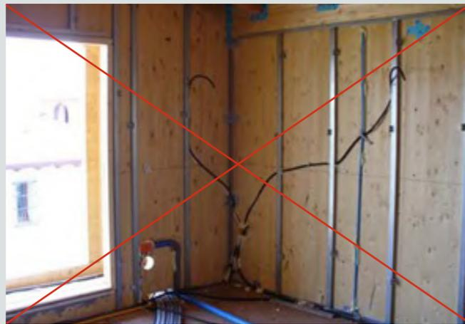
**Figura 4.105** Scorretta posa dei corrugati. Fonte: Gaia L., 2004, Materiale didattico “Impianti elettrici nelle costruzioni in legno”, scaricato da [www.eventoelettromondo.it](http://www.eventoelettromondo.it), pg.53
