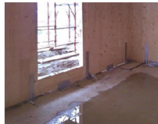
**Figura 4.64** Attacco a terra errato poichè la parete in X-Lam è posata direttamente sulla platea senza una guaina di protezione. Fonte: Ufficio Tecnico Assolegno e ANTIAL (a cura di), 2019, *Appunti per le costruzioni in legno. Concezione, Normativa, progettazione e buone pratiche di cantiere*, documento fornito da Marco Pio Lauriola, pg.81
