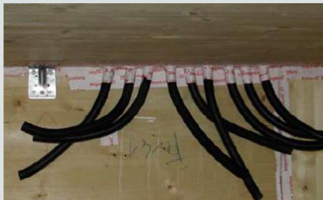
**Figura 4.106** Predisposizione dei corrugati all'interno dei singoli fori di passaggio nel pannello in X-Lam. Fonte: “Ufficio Tecnico Assolegno e ANTIAL (a cura di), 2019, Appunti per le costruzioni in legno. Concezione, Normativa, progettazione e buone pratiche di cantiere, documento fornito da Marco Pio Lauriola”, p. 139
