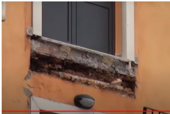
**Figura 4.52** Fotografia in cui si può notare una lesione verticale che si estende dal nodo del balcone all'apertura sottostante. Fonte: [www.youtube.it](http://www.youtube.it)
