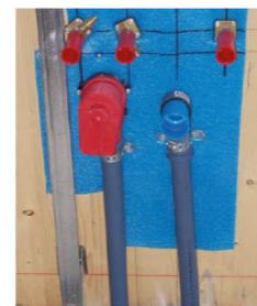
Figura 2.9 Presenza di protezione per la struttura in legno.
