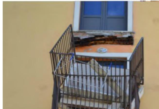
**Figura 4.44** Crollo di un balcone. Fonte: [www.tpi.it](http://www.tpi.it)
