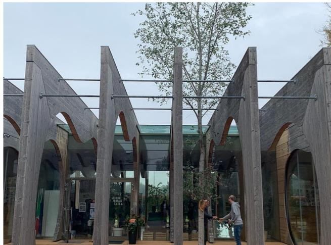
**Figura 4.119** Fotografia dell'edificio: si può notare la scossalina che arriva fino al filo del pilastro del portale ma non protegge la parte frontale della "trave". Fonte: Facebook
