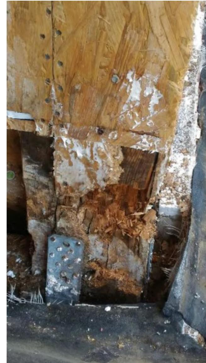
**Figura 4.55** Fotografia dei fenomeni di marcescenza presenti nell'attacco a terra dell'edificio. Fonte: [www.abruzzoweb.it](http://www.abruzzoweb.it)
