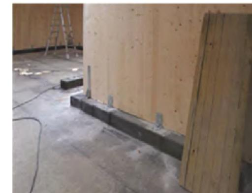
**Figura 4.65** Attacco a terra eseguito correttamente, la guaina bituminosa protegge la parete in legno dalla risalita di umidità. Fonte: Ufficio Tecnico Assolegno e ANTIAL (a cura di), 2019, *Appunti per le costruzioni in legno. Concezione, Normativa, progettazione e buone pratiche di cantiere*, documento fornito da Marco Pio Lauriola, pg.81
