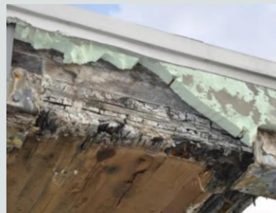
**Figura 3.15** Balcone con struttura in legno soggetto a marcescenza. Fonte: Lauriola M. P., presentazione del 16.03.2021 al seminario: edilizia in legno: le regole del buon costruire, ente Maggioli Spa in collaborazione con Federlegno Arredo e THE PLAN
