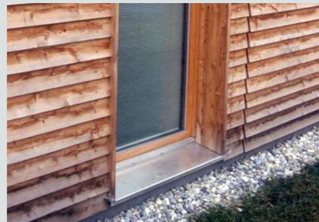
**Figura 4.137** Fotografia in cui il rivestimento nella parte bassa è rovinato per via dell'acqua di rimbalzo. Fonte: Koch C., 2021, Materiale didattico "Holzschutz: Fassaden. Dos and don'ts" del seminario "Modul I Konstruktion/Bemessung/Holzschutz" organizzato da ProHolz il 19 Maggio 2021, scaricato da [www.proholz.at](http://www.proholz.at), pg.44
