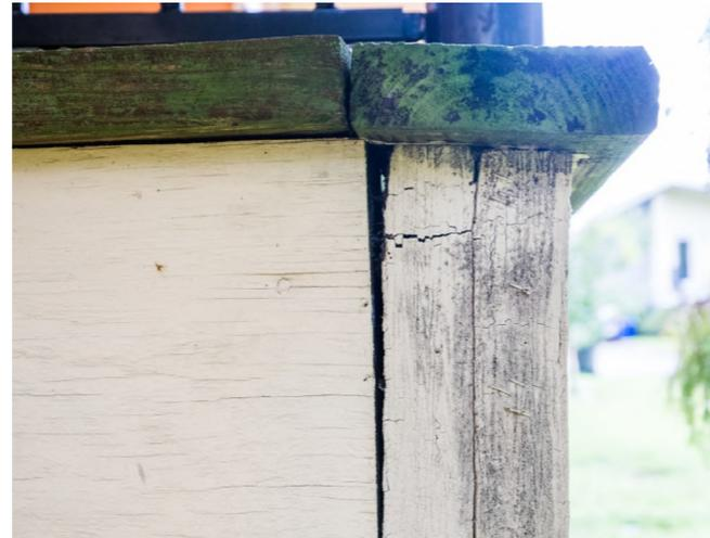
**Figura 4.86** Progettazione assente in funzione delle 4D: scelta di materiali non durevoli. Fonte: [www.nola.com](http://www.nola.com)
