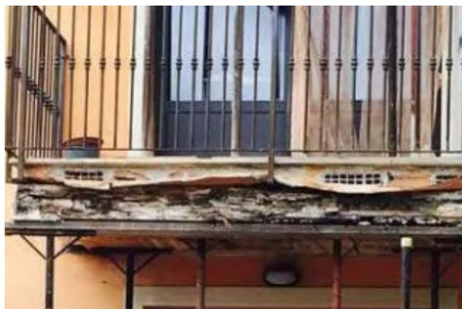
**Figura 4.48** Fotografia balcone: struttura in X-Lam, getto e mattoni. Fonte: [www.abruzzoweb.it](http://www.abruzzoweb.it)
