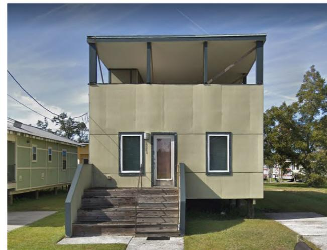
**Figura 4.71** Fotografia dell'edificio novembre 2018: si notano i pannelli rigonfiati per via dell'acqua di infiltrazione. Fonte: [Google Maps](https://www.google.com/maps)
