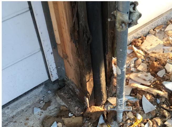
**Figura 4.96** Pilastro in legno fresato per il passaggio di un pluviale, riduzione della sezione resistente. Fonte: anonima
