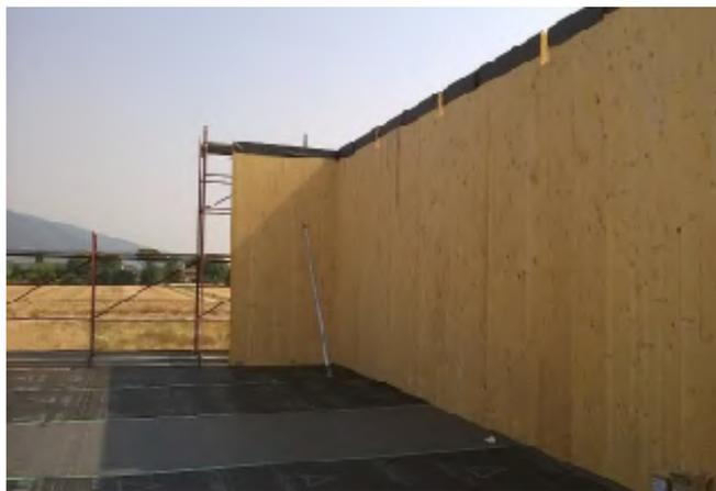
**Figura 4.40** Protezione delle teste delle pareti con guaine traspiranti durante il cantiere. Fonte: Ufficio Tecnico Assolegno e ANTIAL (a cura di), 2019, *Appunti per le costruzioni in legno. Concezione, Normativa, progettazione e buone pratiche di cantiere*, documento fornito da Marco Pio Lauriola
