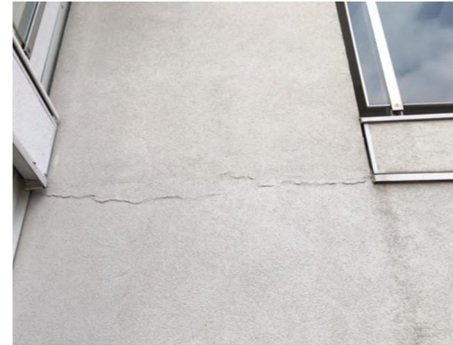
Figura 4.11 Fessurazione derivante dal ritiro dell'intonaco.
