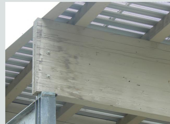
**Figura 3.6** La trave in legno non viene protetta dallo sporto del tetto e questo potrebbe portare a fenomeni di marcescenza e riduzione della resistenza. Fonte: Follesa M., Lauriola M.P., Moschi M., 2011, Durabilità e manutenzione delle strutture in legno, Milano, Ticom Srl – Piacenza, p. 59
