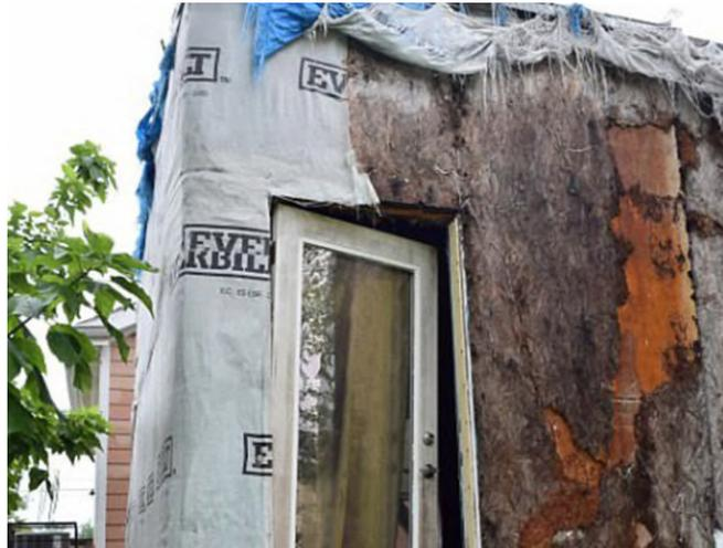
**Figura 4.85** Progettazione assente in funzione delle 4D: mancanza di asciugatura. Fonte: [www.thisischriswhite.com](http://www.thisischriswhite.com)
