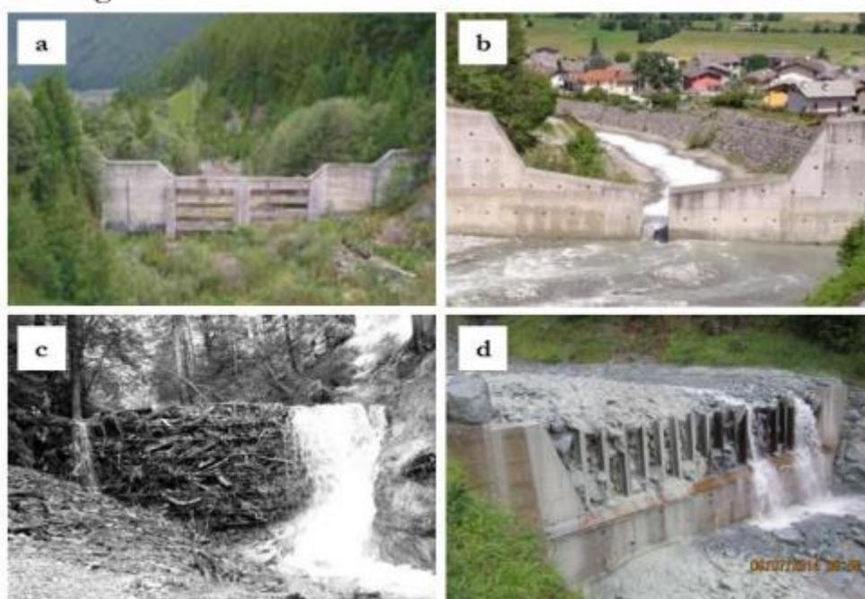
*Figura 4.8* Tipologie di briglie filtranti (a) a finestre; (b) a fessura; (c) a reticolo; (d) a pettine (Pirulli, 2021)
