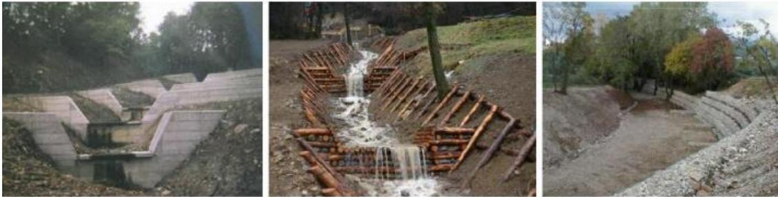
*Figura 4.5 Opere di consolidamento trasversali (a sinistra e al centro) e longitudinali (a destra) (Pirulli, 2021)*
