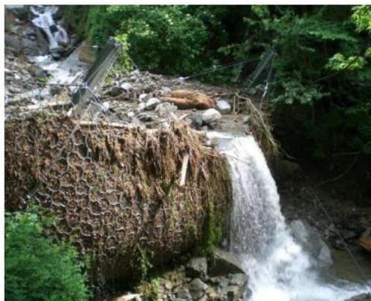
Figura 4.11 Barriera in rete riempita con successo dopo un fenomeno di colata (Geobruigg, 2021)
