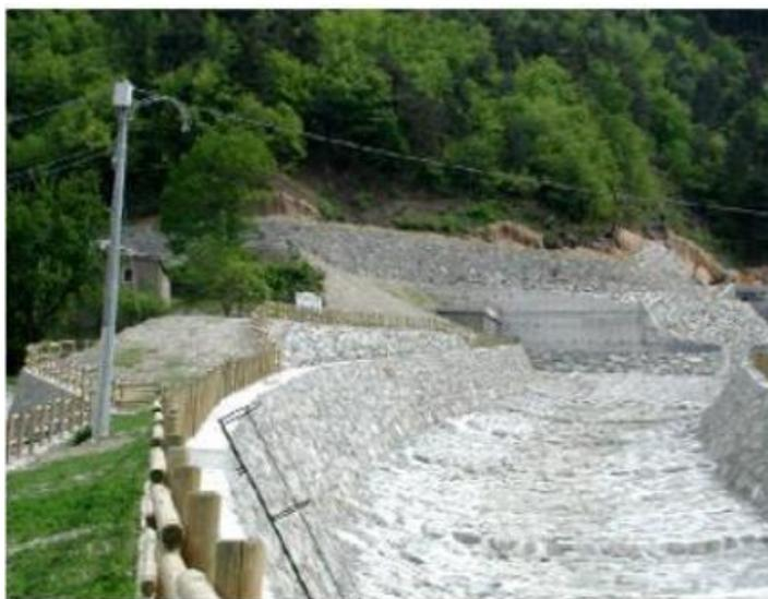
*Figura 4.12 Canale di smaltimento rivestito con blocchi lapidei (Pirulli, 2021)*
