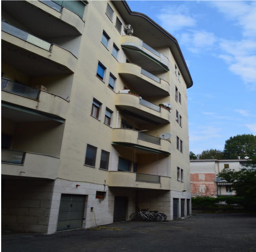
Facciata condominio Via Vittori 4
