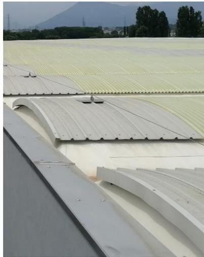
Figura 3.4: Pannello curvo coibentato utilizzato per la copertura del capannone produttivo e dello showroom
