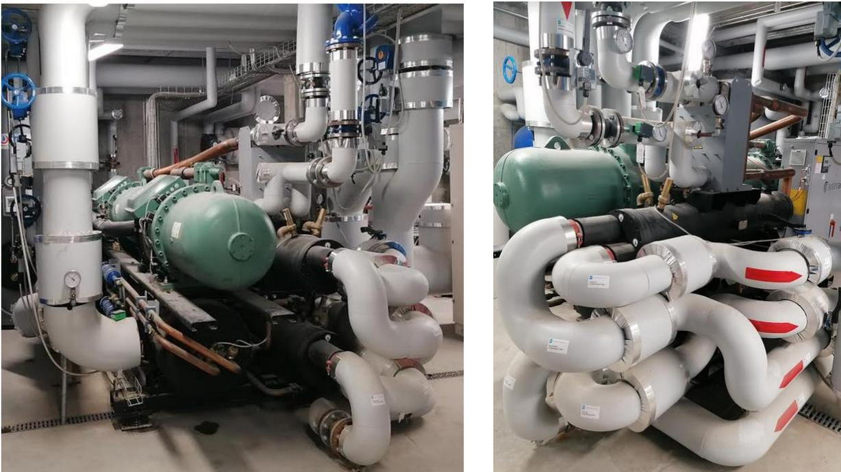
*Figura 3.17: Pompa di calore Systemair di Fase 2*
