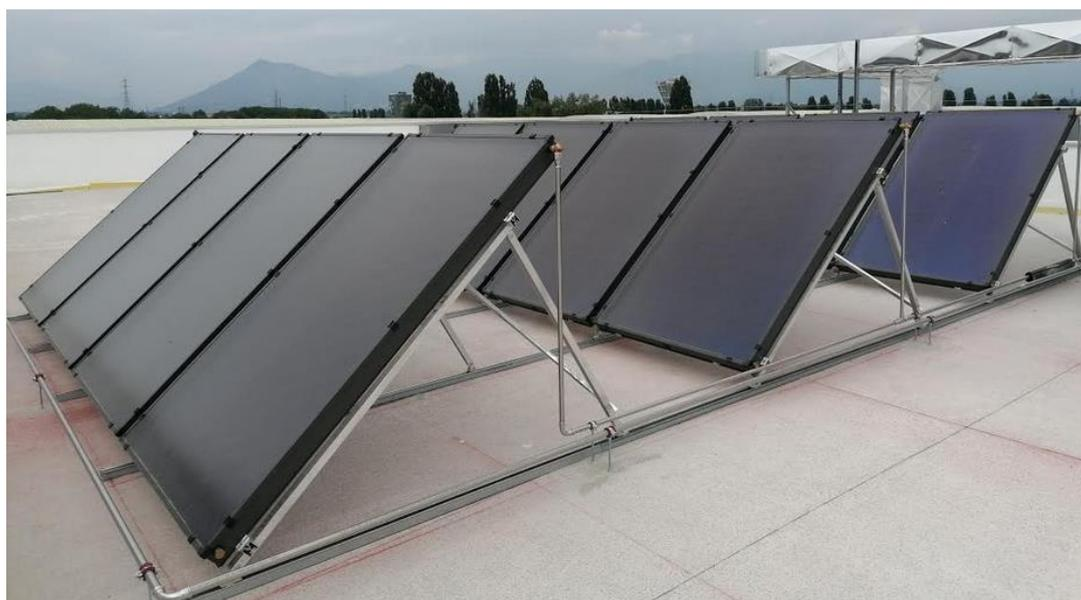
Figura 3.23: Pannelli solari termici per l'ampliamento di Fase 3
