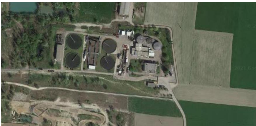
Figura 6.27. Impianto depurazione acque reflue di Cassano Spinola (Maps, 2021)
