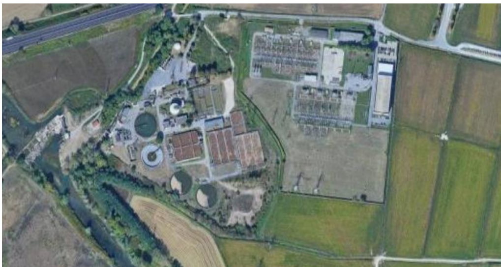
Figura 6.9. Impianto depurazione acque reflue di Novara (Maps, 2021)
