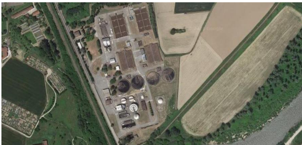
Figura 6.24. Impianto depurazione acque reflue di Asti (Maps, 2021)
