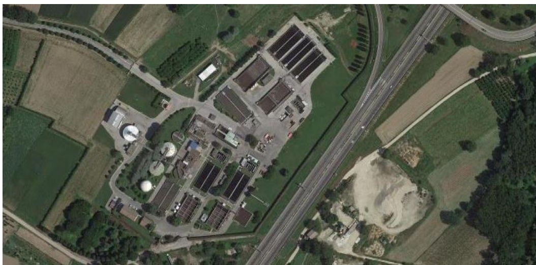
Figura 6.18. Impianto depurazione acque reflue di Canove di Govone (Maps, 2021)
