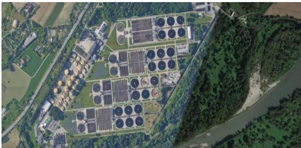
Figura 6.15. Impianto depurazione acque reflue di Castiglione Torinese (Maps, 2021)
