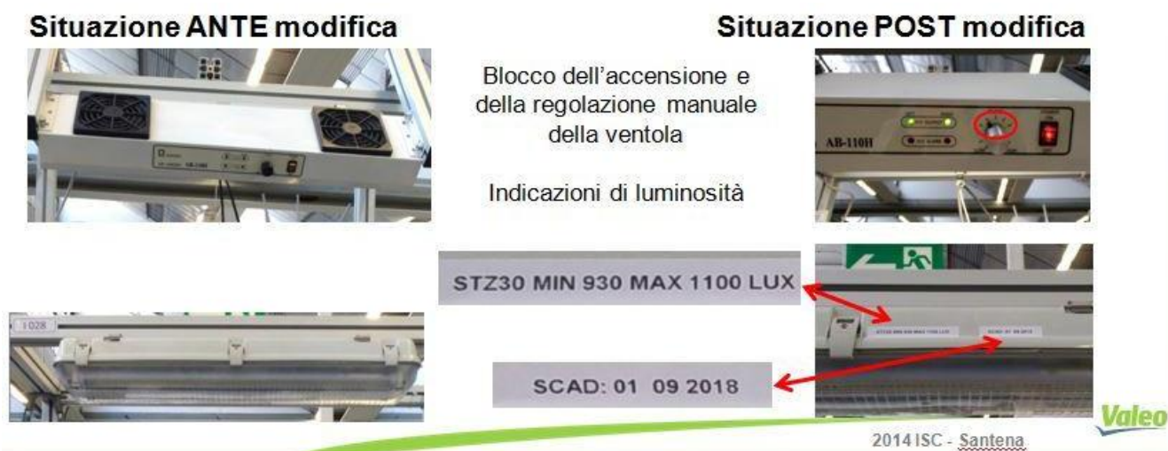
Figura 5-11 : Caratteristiche di illuminazione di linea
