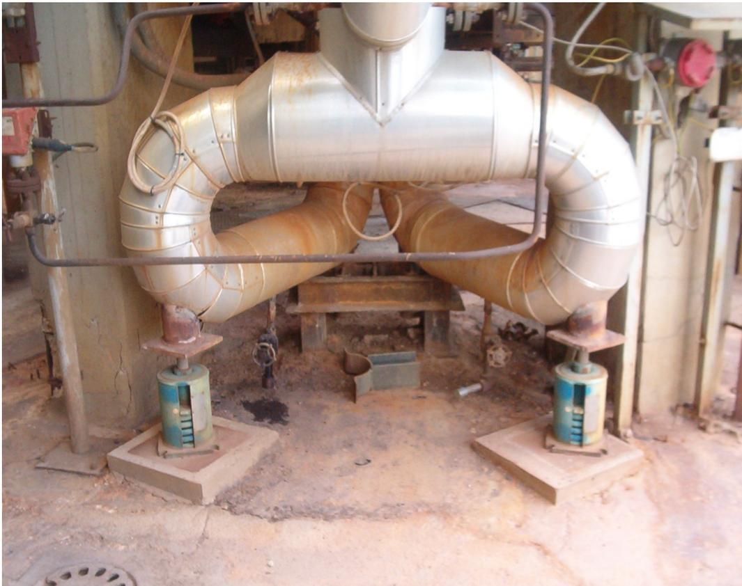
Figura 3.2: Coppia di supporti variabili appoggiati installati presso lo stabilimento Sasol italy Spa, Augusta (SR) – Italiaa
