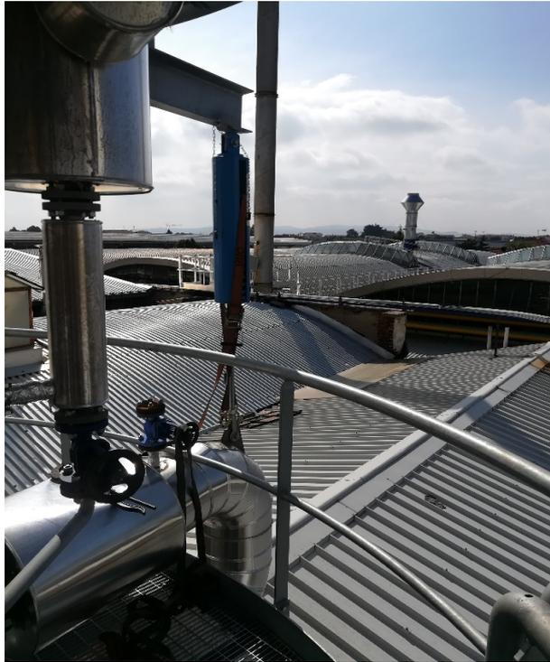
Figura 3.1: Supporto variabile appeso installato presso lo stabilimento Arpa Industriale S.p.A, Bra (CN) – Italia
