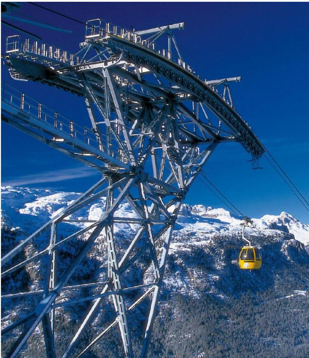
Figura 1-5: Sostegno con struttura a traliccio – visita a impianto 'Piz la Ila' a La Villa (BZ)
