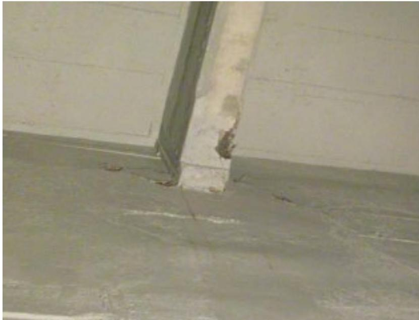
*Figure 3.7: Segni di scorrimento tra trave longitudinale e setto frontale della pila*
