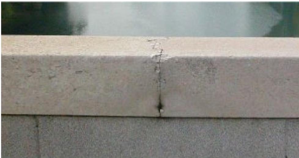
*Figura 3.9: Sbriciature per compressione del coronamento in pietra*
