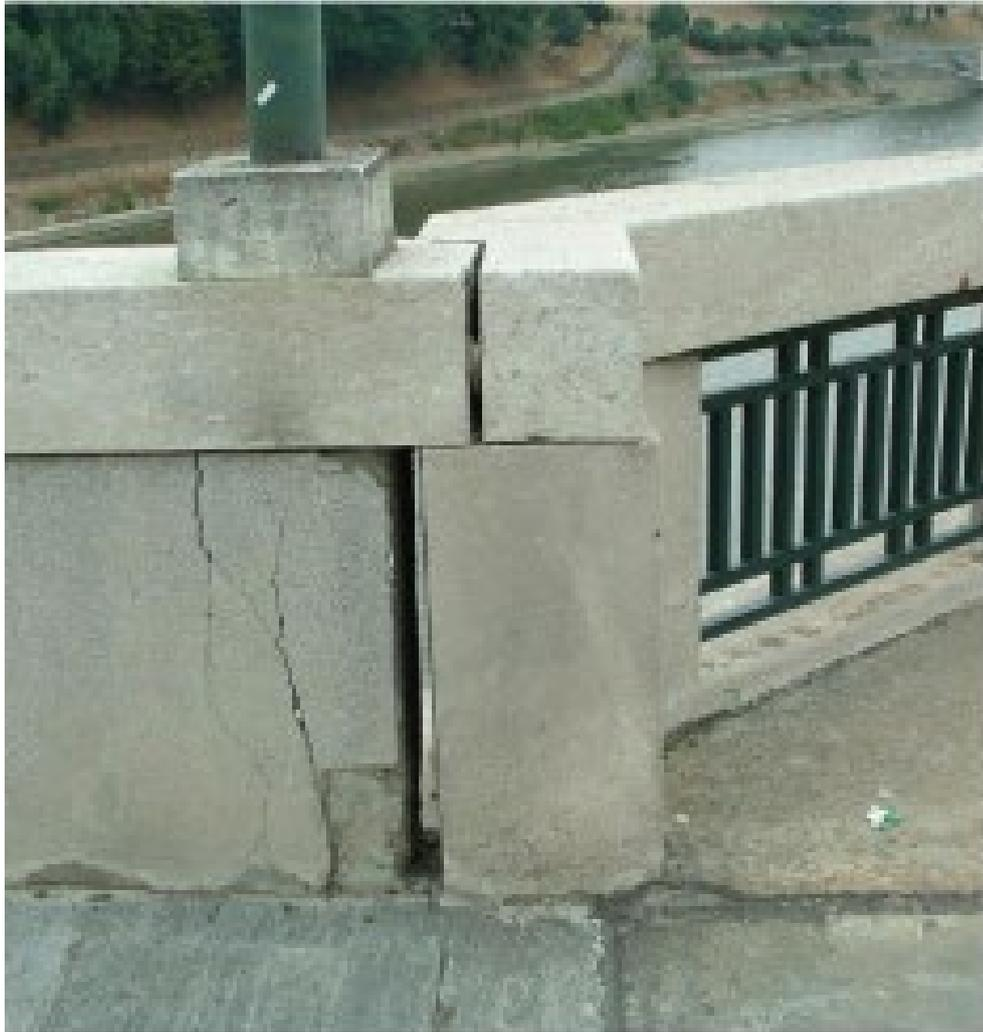
*Figura 3.8: Dissesti del parapetto in corrispondenza delle lesioni del timpano*
