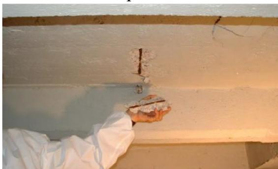
*Figura 3.5: Espulsione del copriferro causata dal rigonfiamento di un'armatura ossidata*
