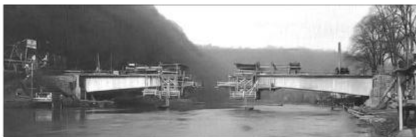
Figura 3: Ponte di Balduinsten. Fase di costruzione dei conci tramite casseri mobili; essendo un impalcato a campata unica le estremità laterali sono dotate di contrappeso per sostenere la costruzione a sbalzo.
