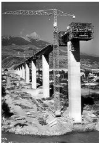
Figura 4: Il ponte di Savines, progettato da J. Courbon e realizzato dalla SGTM. È una delle prime opere costruite in Francia ad avanzamento bilanciato. Le stampelle risultano tra loro incernierate.
