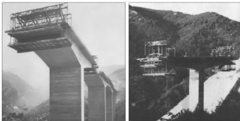
Figura 7: Ponti sul torrente Nervi e sul torrente Cubia, rispettivamente opera di Zorzi e di Cestelli Guidi. figura 8 e 9 prima
