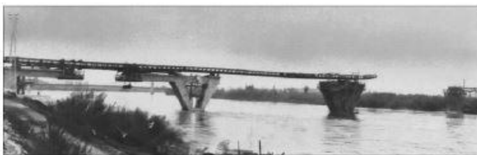
Figura 9: L'impalcato, realizzato con carro di varo superiore conquista il record di lunghezza per i viadotti ferroviari
