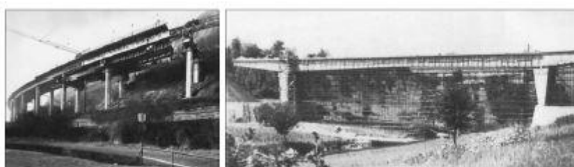
Figura 10: a sinistra il viadotto di Krahnenmberg, a destra il ponte San Nicola
