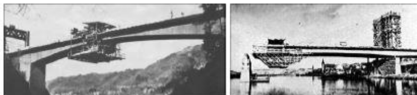
Figura 8: A sinistra il ponte di Ranzan, a destra il ponte sul fiume Maine a Karlstadt figura 10 e 11 prima
