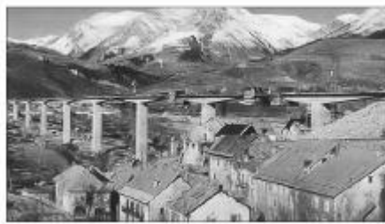
Figura 5: Ponte di Savines
