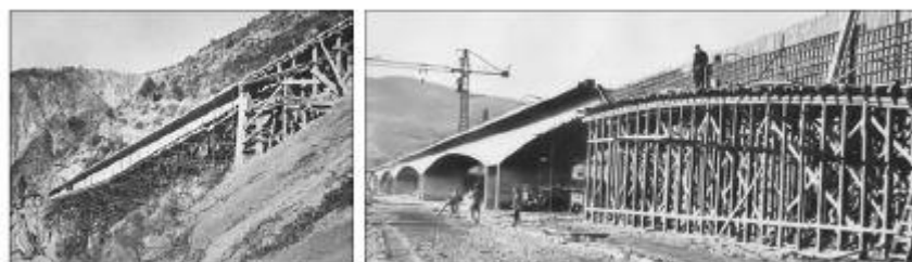
Figura 6: A sinistra il ponte per l'impianto del Mucone realizzato con sistema di precompressione Freyssinet. A destra il ponte sul fiume Bradano con impalcato realizzato con sistema di precompressione Morandi
