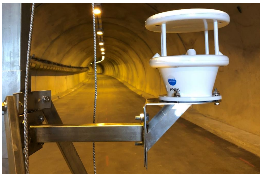
Figura 5.1 Montaggio dell'anemometro sul supporto.
