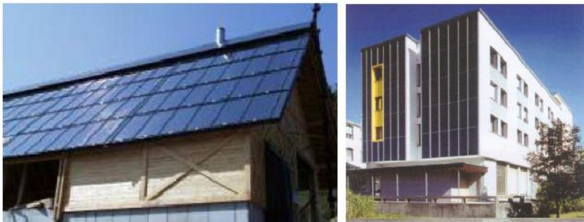
Figura 29: Esempio di installazione in cui l'impianto solare funge anche da copertura o facciata [24].
