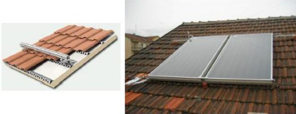
*Figura 26: Esempio installazione collettori solari con ancoraggio alla copertura [24].*
