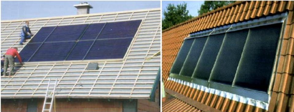
*Figura 27: Esempio di integrazione completa nella copertura a coppi [24].*
