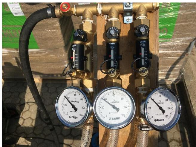
Figura 65: Flussometri e pozzetti con termometri bimetallici Caleffi ad immersione.
