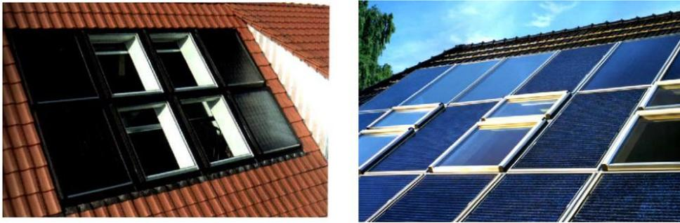
Figura 28: Esempio di integrazione con finestre da tetto e solare fotovoltaico [24].
