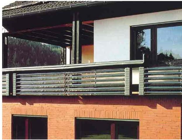
*Figura 30: Collettori a tubi sottovuoto utilizzati come ringhiera di un terrazzo [25].*
