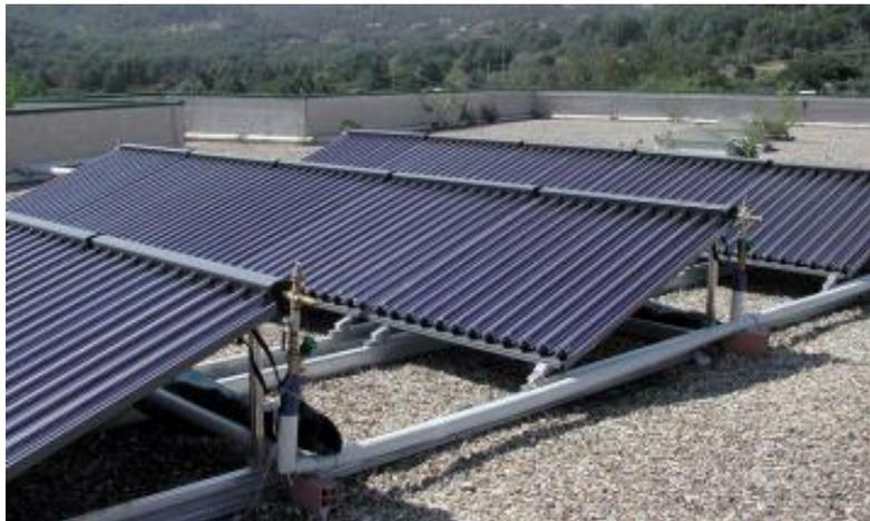
*Figura 25: Esempio di installazione di collettori solari su copertura piana [23].*
