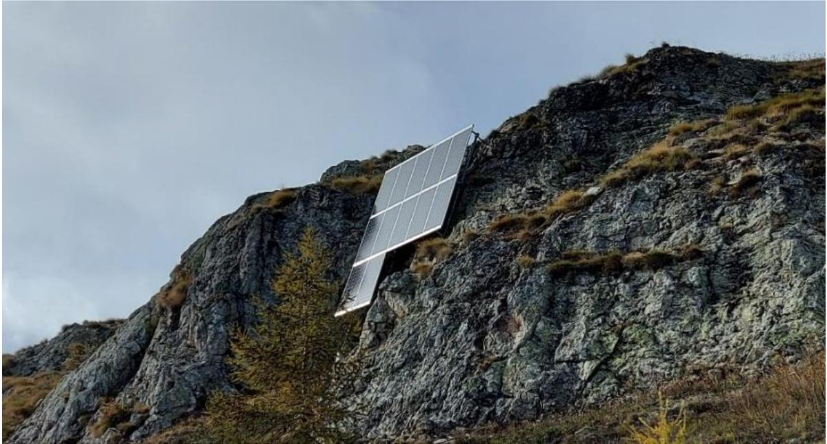
*Figura 42 - Impianto fotovoltaico verticale rivolto a sud*
