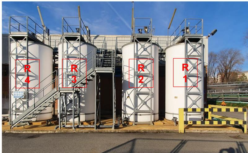
Figura 15-Reattori sezione FENTON
