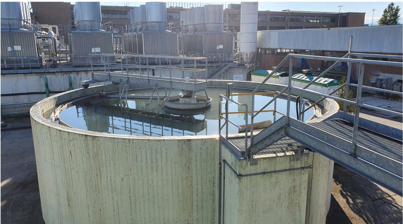
*Figura 11-Sedimentatore secondario circolare*
