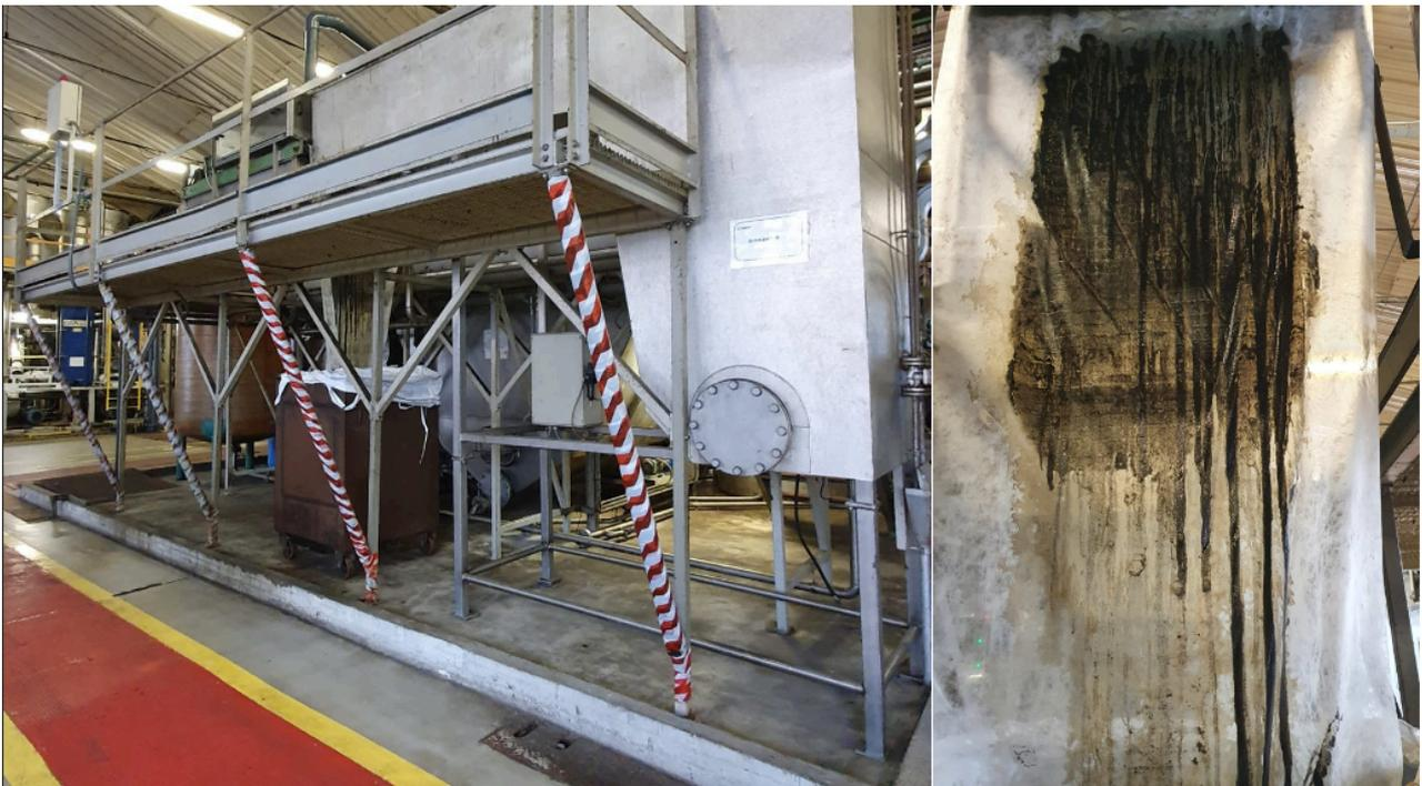
Figura 20-Disoleatore a caldo - Filtro carta
