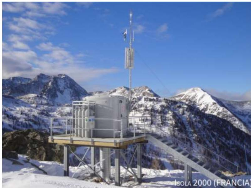
*Figura 3.10 Deposito bombole di ossigeno e propano (tas.fr)*
