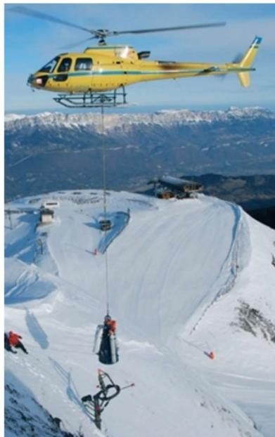
*Figura 3.16 Posa del sistema O'bellx sul pendio tramite elicottero*
