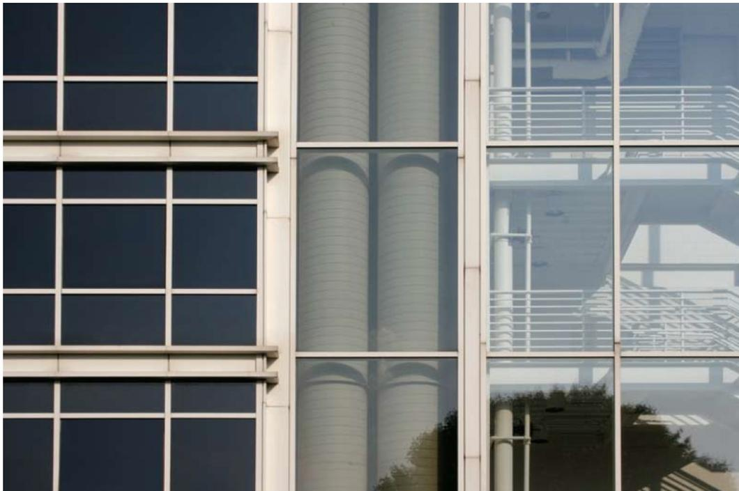
Fig. 15 Frame di facciata continua come cornice caratterizzata da variazioni multiple in termini di materiali e forme. [23]
