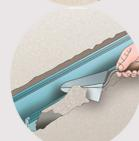
B. Ricompacte per bene il terreno attorno allo scavo, badando che il filo superiore della canalina sia poco più alto del livello del terreno.
