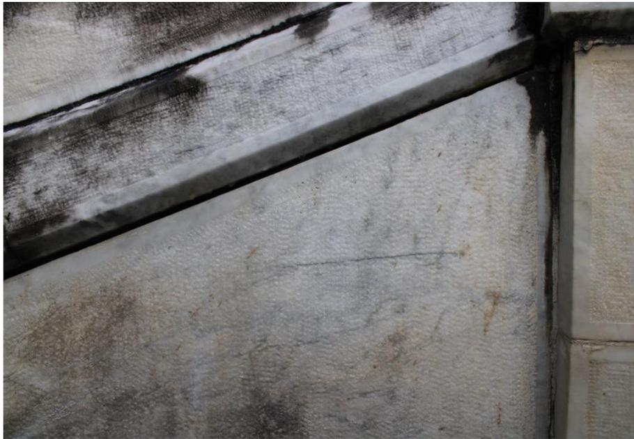
Figura 56 fotografia dei blocchi di marmo, lavorati meccanicamente per creare la finitura, del paramento murario a sostegno delle rampe d'accesso alla Basilica. Scattata il 03.01.2021
