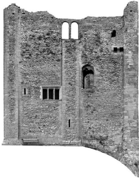
Figura-23 esempio di rilievo fotogrammetrico, utile per rappresentare i prospetti qualora vi siano complicazioni nella raccolta di misure sufficienti. (Graham Abrey, *Condition surveys of masonry ruins*, in John Ashurst, *Conservation of ruins*, Burlington: Elsevier, 2007, p.75);
