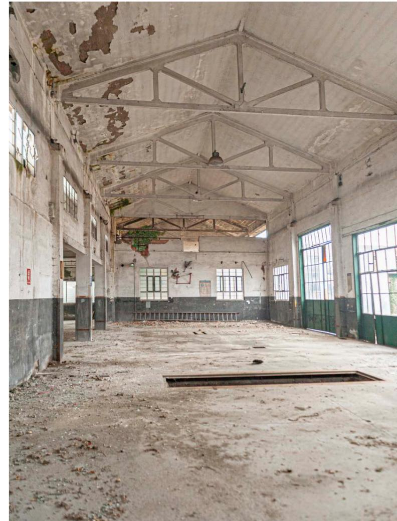
Fotografia 121- Interno dell'edificio prefabbricato in calcestruzzo armato. Corte nord est, lato sud
