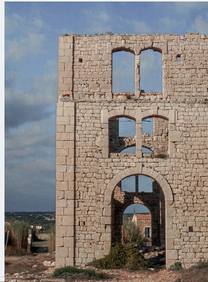
31 FOTO DI DETTAGLIO ARCATA PROSPETTO SUD
