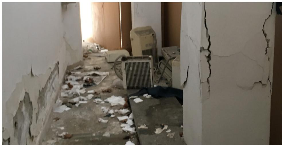
Fig. 3.85, stato di degrado pilastro interno. Foto concessa dall'Autorità Portuale.
