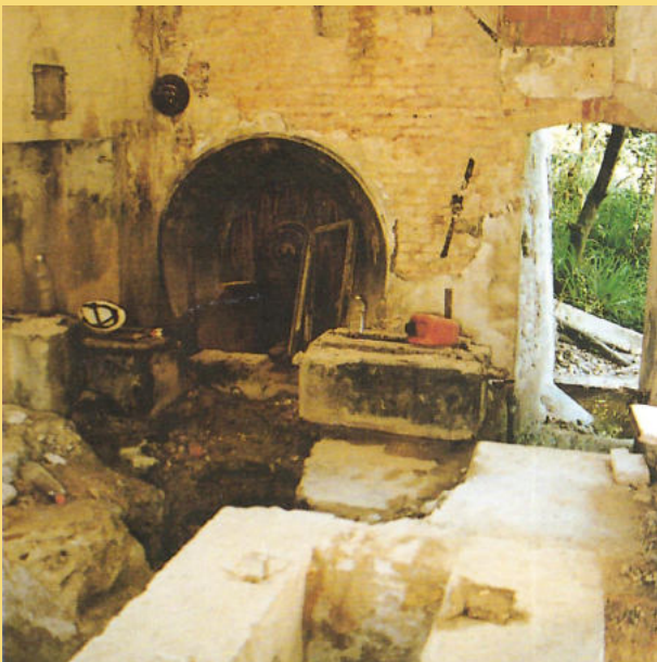
Restauro della cartiera Galvani di S.Valentino. In primo piano è il basamento settecentesco del sostegno dell'asse in legno della ruota idraulica. Il disco scuro sulla parete è la parte libera della turbina idraulica collocata agli inizi del Novecento. (foto a.) 7
