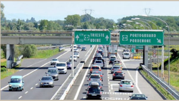
Svincolo Autostrada A4 direzione Trieste uscita Portogruaro/Pordenone.
