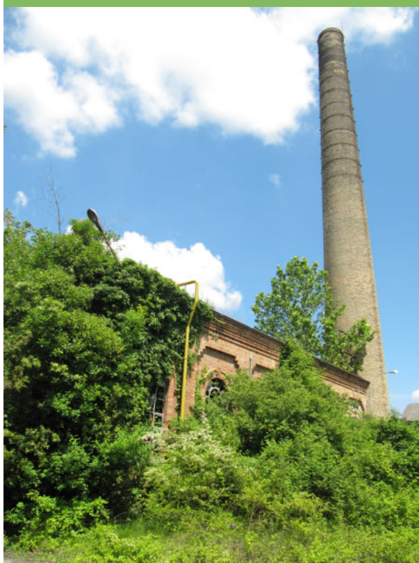
La ciminiera con ai suoi piedi l'ex centrale termica. 8 Fonte: foto scattata da Filippo Enna il 24/05/2019
