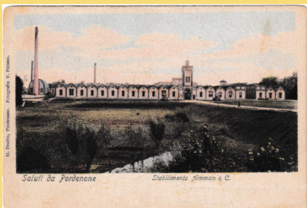
Inizi Novecento: il fronte principale del Cottonificio Amman. 12
