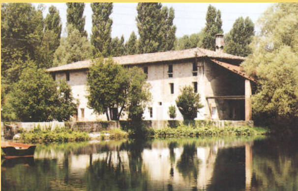
Il grande edificio superstite costruito in riva al lago del Maio della Vallona. (foto a.) 7
