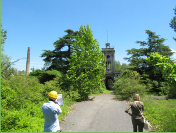
Fronte principale dell'ex Cotonificio Amman Wepfer con al centro la torre dell'orologio. 4 Fonte: foto scattata da Filippo Enna il 24/05/2019
