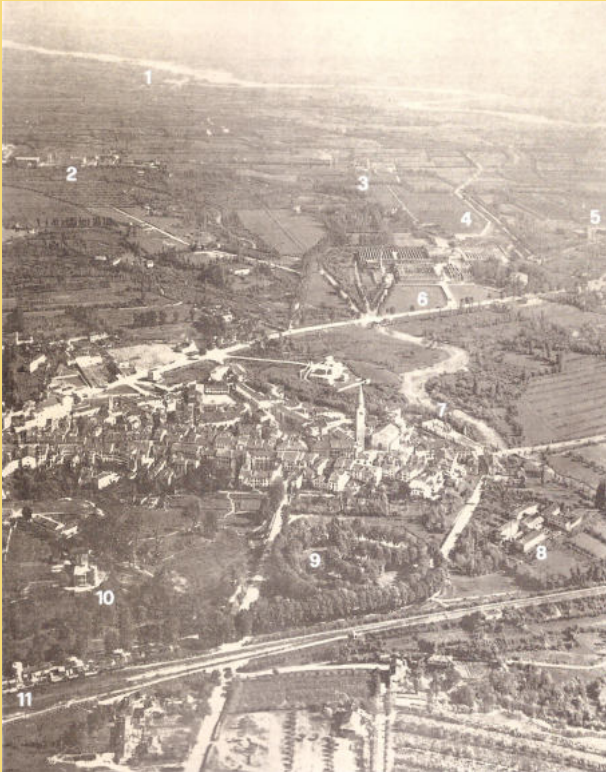
Foto aerea del 1920 circa dove si vede la città ancora in via di espansione. Si individuano: 1 fiume Meduna; 2 Cottonificio Veneziano di Torre; 3 Fornace Vuga; 4 canale Meduna lungo 7 km; 5 Dormitorio femminile Amman; 6 Cottonificio Amman con gli scarichi dei due canali Meduna e Noncello nell'antico alveo; 8 Seteria Fratelli Marcolini; 9 Foro Boario; 10 Villa Querini; 11 Stazione FS. 12
