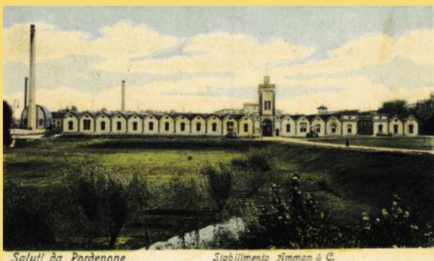
Inizi Novecento: il fronte principale del Cottonificio Amman. 14
