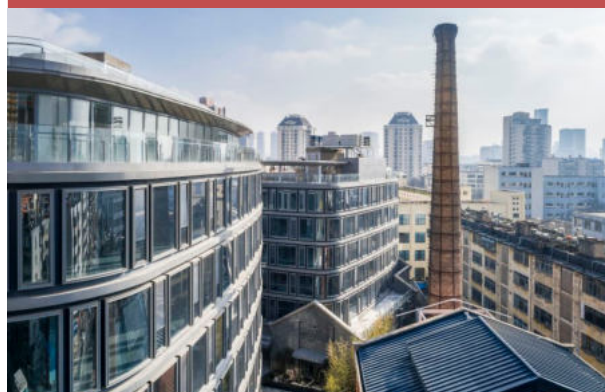
Il complesso dopo l'intervento di recupero 2
