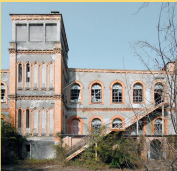
Il Cottonificio Makò oggi, in stato di abbandono. 4
