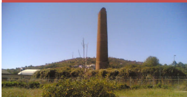
Come si presentava la fornace prima del restauro 4
