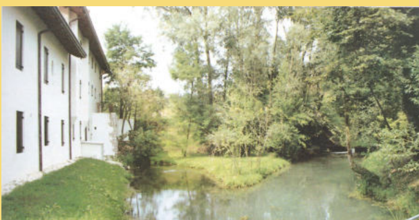
Il lato della Cartiera di S. Valentino, dove un tempo c'erano due ruote idrauliche, come appare dopo il restauro. La scarpata pian-tumata sullo sfondo è il terrapieno della diga del laghetto. (foto a.) 8
