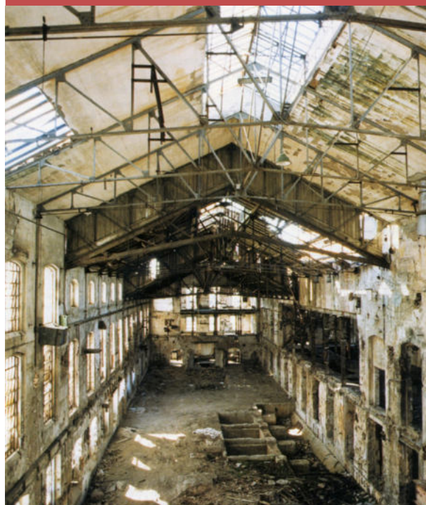
Lo zuccherificio prima dell'intervento di recupero 3
