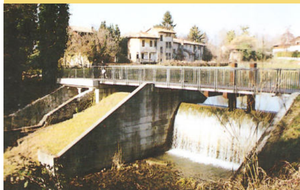
La diga in terra battuta del lago di S. Carlo con in primo piano il nuovo deturpante scarico in cemento armato costruito intorno al 1993. In secondo piano si osserva lo scarico ottocentesco. 3
