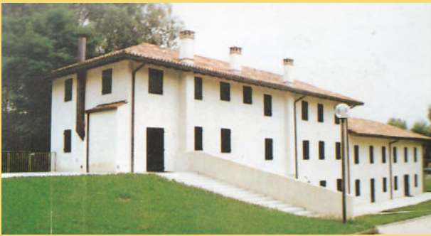
La Cartiera Galvani di S. Valentino dopo il restauro del 1996/97. (foto a.) 5
