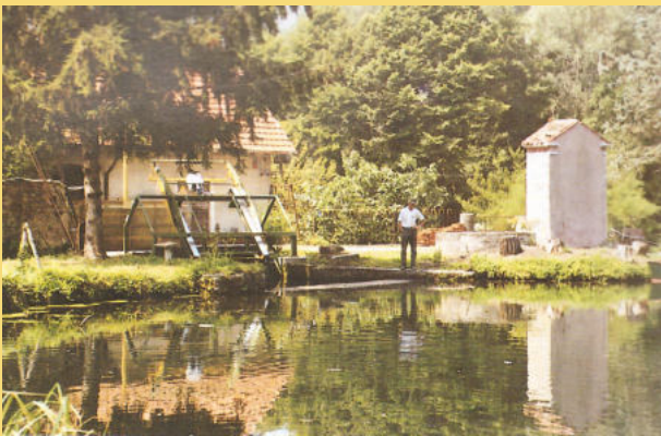
Lungo la diga del lago della Vallona ove un tempo erano gli edifici dei magli, c'è da oltre un secolo una centrale elettrica. Sopravvivono ancora i pilastri delle antiche paratoie. Una edicola votiva prende forse il posto di una precedente. (foto a.) 6
