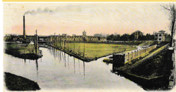
Inizi Novecento: la biforcazione del fiume Noncello con a destra il canale di carico e a sinistra il proseguimento del fiume. Da notare partendo da destra la portineria con l'ingresso e subito dopo in mezzo agli alberi la residenza padronale. 11
