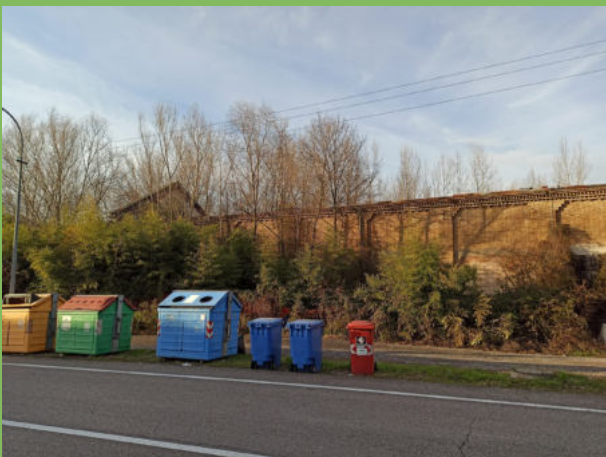
Edificio del complesso che affaccia su Via Canaletto. 6 Fonte: foto scattata da Filippo Enna il 24/01/2021
