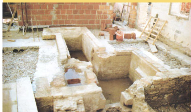
Emergenze di archeologia industriale durante i lavori di restauro alla Cartiera di S. Valentino nel 1996. Sono le vasche di "purga" degli stracci prima della triturazione. (foto a.) 4
