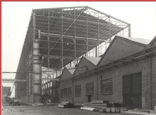
HangarBicocca, il reparto trasformatori in costruzione, 1963, 2
