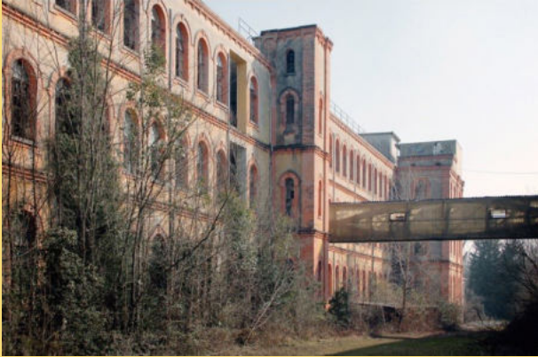
Il Cottonificio Makò oggi, in stato di abbandono. 2
