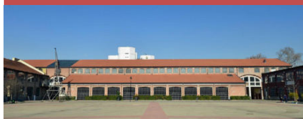
La fabbrica del vapore oggi, 4
