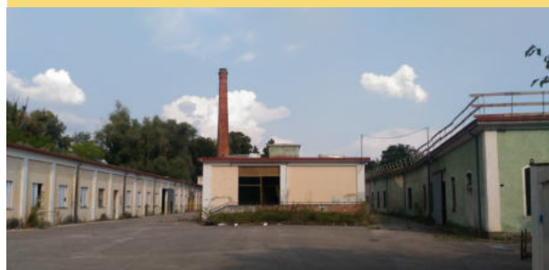
31/08/2019 La tintoria di Torre poco prima dell’inizio dei lavori di demolizione. 3
