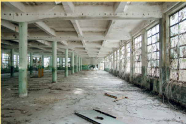
Una delle sale all'interno del cotonificio di Torre con le colonne in calcestruzzo di epoca più recente. 17
