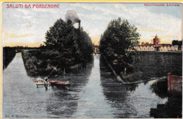
Anno 1905: il canale di carico, derivato dal Noncello che scorre verso l'interno del Cottonificio Amman. 5
