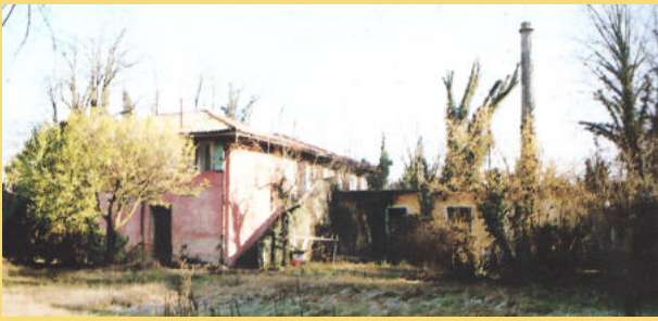
L'edificio del battirame di S. Carlo oggi dopo trent'anni di abbandono. A sinistra iniziava il capannone della centrale; in color rosa la parte ottocentesca. A destra la ciminiera del forno da silice con il piccolo edificio del 1923. (foto a.) 4
