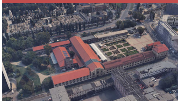
La fabbrica del vapore oggi, 6
