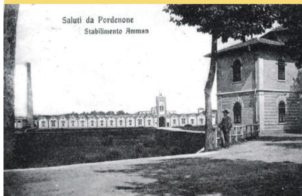
Inizi Novecento: il fronte principale del Cotonificio Amman. A destra la portineria e l'ingresso. 16
