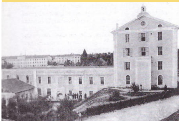
Tessitura di Rorai del 1846 (palazzo di destra) con alcune costruzioni successive. Sullo sfondo il Cotonificio (incannatura) e la palazzina dei dirigenti. Foto 1896 circa. (collezione Gino Argentin) 5
