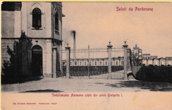
Anno 1906: la portineria e l'ingresso principale del Cottonificio Amman. 6
