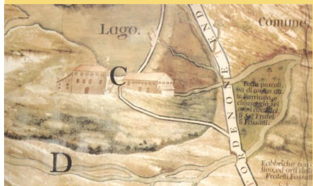
La Cartiera Galvani con il lago di San Valentino nel 1776. Sono osservabili due edifici, quello con le ruote idrauliche a destra e l'altro per le lavorazioni ausiliare. Particolare. (collezione privata) 3
