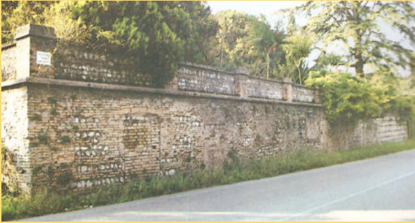
Il muro che costeggia via della Tessitura non è che una delle pareti dell'edificio maggiore dei due che costituivano il Maj. Vi si notano in tutta chiarezza porte e finestre tamponate. (foto a.), 11
