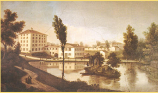
Veduta della Tessitura di Rorai Grande del 1846 con il romantico lago inferiore in un affresco di Paolo Pajetta del 1854. I telai, per buona parte in legno, erano nel grande edificio sulla sinistra. L'androne presente nella piccola costruzione al centro era il passaggio del canale d'acqua per la turbina. Sullo sfondo verso destra si scorge villa al Maj. (Palazzo Porcia-Pordenone), 1
