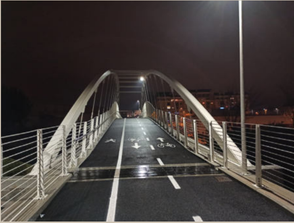
La passerella ciclopedonale vista dal piano di calpestio. 5 Fonte: foto scattata da Filippo Enna il 24/12/20
