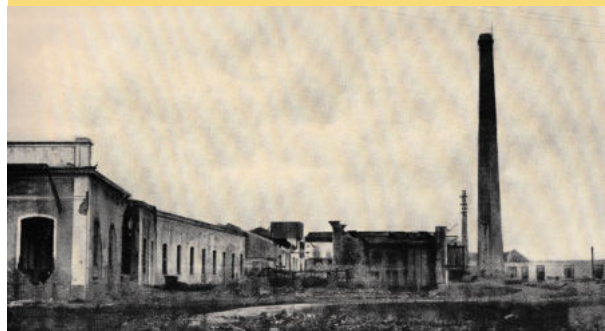
La tintoria di Torre dopo l’invasione nemica del primo conflitto mondiale ove è possibile vedere la ciminiera “sana e salva” (ciminiera che sopravviverà anche al secondo conflitto mondiale). 1
