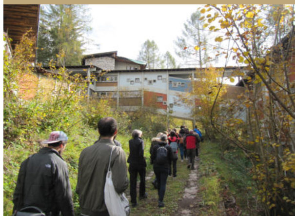
Visita presso l'ex villaggio eni di Borca di Cadore, complesso oggetto di un programma di valorizzazione e rifunzionalizzazione avviato da dolomiti contemporanee nell'estate 2014. 3 Fonte: foto scattata da Filippo Enna il 20/10/2019
