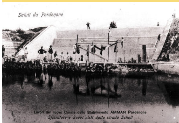
Inizi Novecento: lavori del nuovo Canale dello Stabilimento Amman di Pordenone. Sfiatore e Scavi visti dalla strada Scholl. 10
