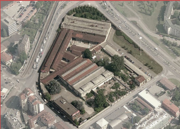
Il complesso della forgiatura prima dell'intervento di riqualificazione,
