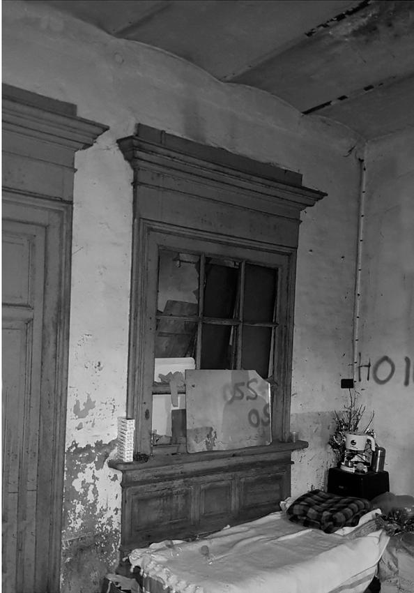
Fotografia dell'atrio del fabbricato, si nota il solaio intonacato a voltini e putrelle (D. Filippa, 2020).
