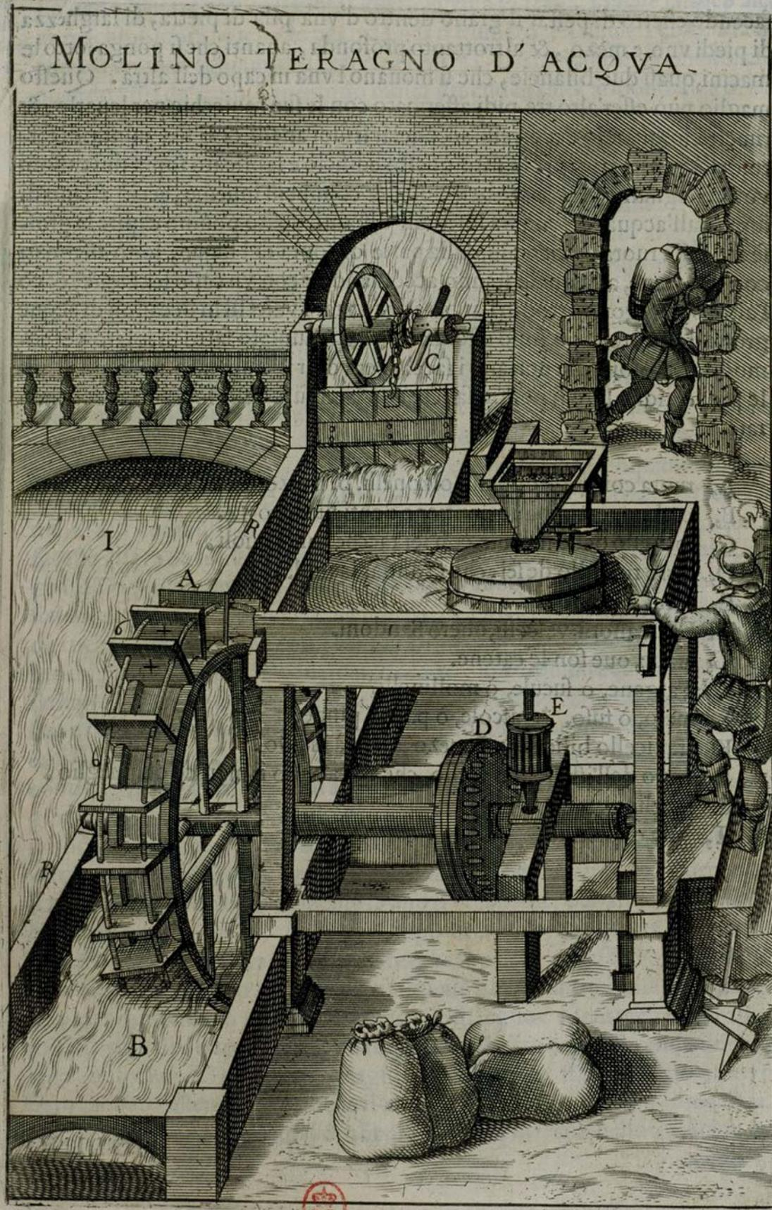
◀ **Benché l'immagine riguarda un Mulino di modeste dimensioni in pianura senza l'edificio contenitivo dei macchinari, possiamo vedere in maniera generale il funzionamento di tale macchina per la macinazione cerealicola.**
