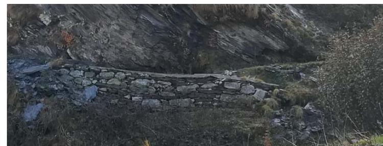
▼ Muro a secco in materiale lapideo su cui appoggiano le opere di contenimento delle acque in cemento sostituite nel restauro del 1949
