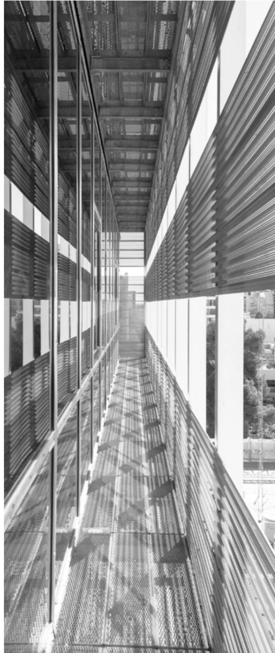
**Fig. N.** Intercapedine della facciata ventilata con particolare della maglia metallica. Foto di *Dinamo Arquitectura*.
