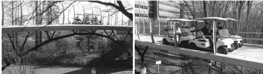
Figura 4.4: Quattro macchine da golf usate come carico viaggiante [1]
