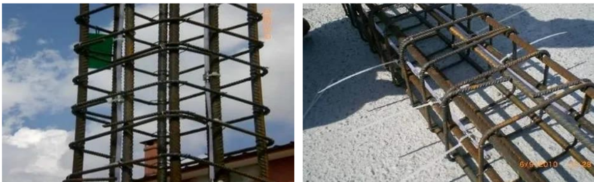
Figura 9 - Sensori a fibra ottica fissati alle barre delle armature all'interno degli elementi strutturali
