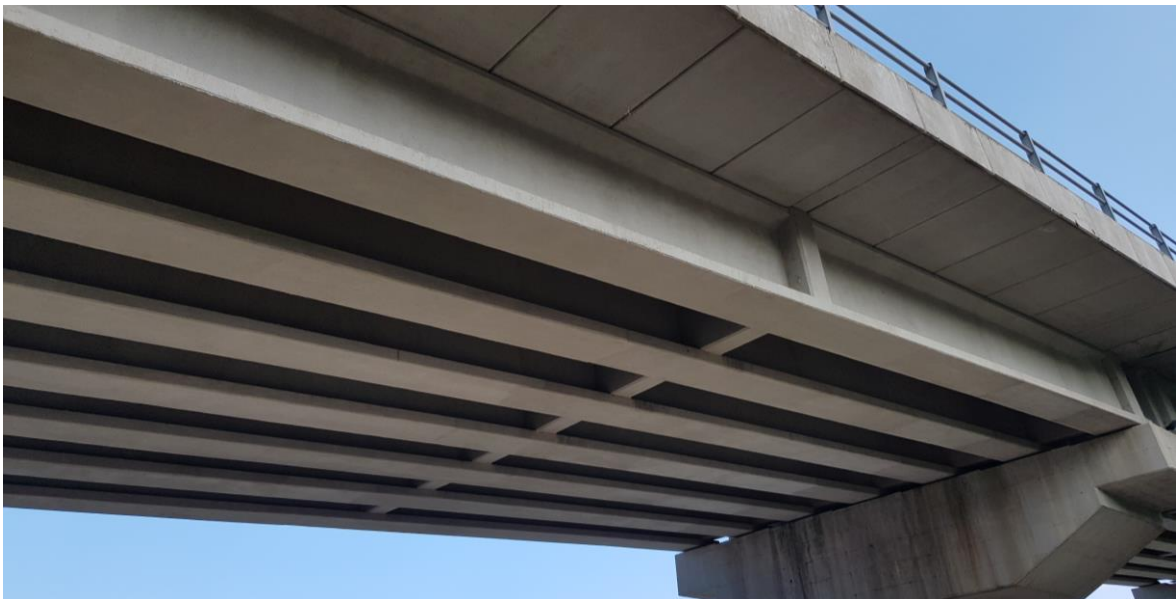
Figura 20 – Impalcato in calcestruzzo armato precompresso
