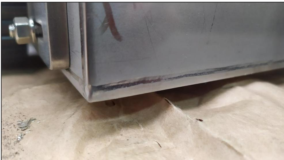
*Figura 41 - Dettaglio di uno spigolo di saldatura continua delle lamiere dello chassis, lato esterno*
