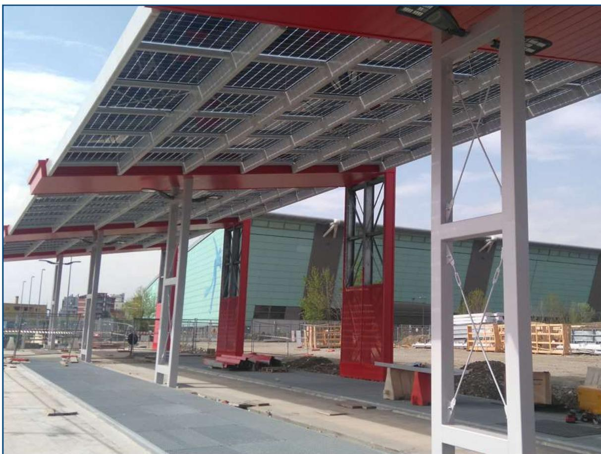
Figura 18. La Promenade fotovoltaica: fotografia scattata in cantiere.
