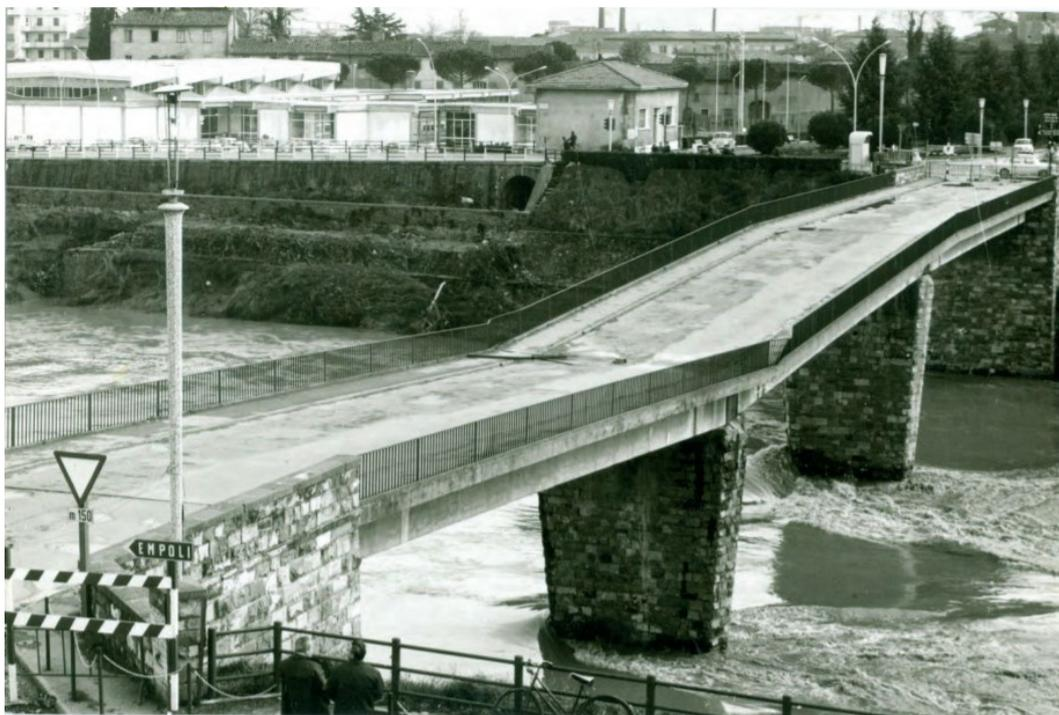
**Figura 11** Cedimento Ponte sul Ponte Sull'Arno
