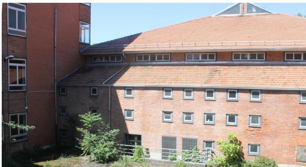
Figura 68. Prospetti della palestra e del corpo avanzato della terna nord in affaccio allo spazio a quota inferiore; in evidenza, nel corpo avanzato, il tratto di muratura sostituito. (foto Sabrina Scala)
