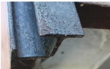
I profili metallici a T che affiancano gli infissi sono integrati direttamente nella muratura e fissati tramite saldatura ai davanzali esterni. Nei tratti angolari, due profili a T sono saldati tra loro, sporgendo inferiormente di 7 cm
