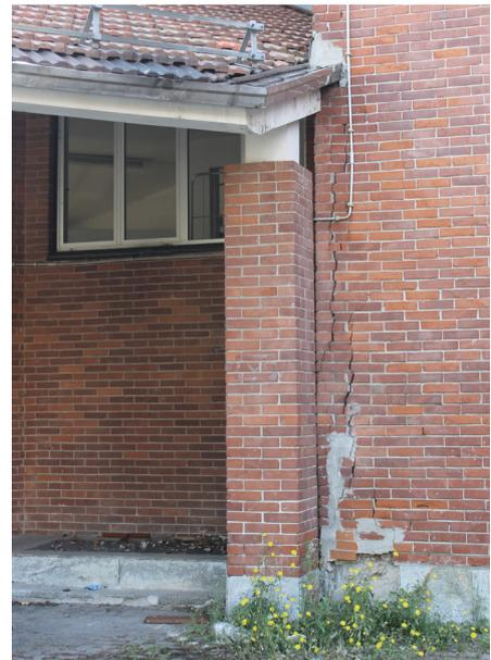
Figura 88. Uno dei pilastri strutturali inseriti a sostegno dello sporto della galleria, in seguito ai problemi di natura statica. (fonte: foto di Sabrina Scala, 11 luglio 2020).
