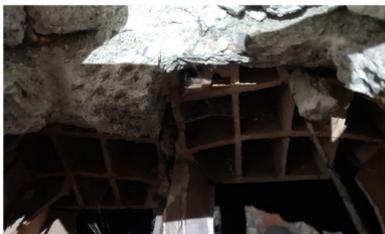
Secondo il Capitolato Particolare d'appalto, gli orizzontamenti dei vari piani risultano misti in conglomerato cementizio e laterizi cavi. È stato possibile verificare la stratigrafia del solaio del seminterrato.
