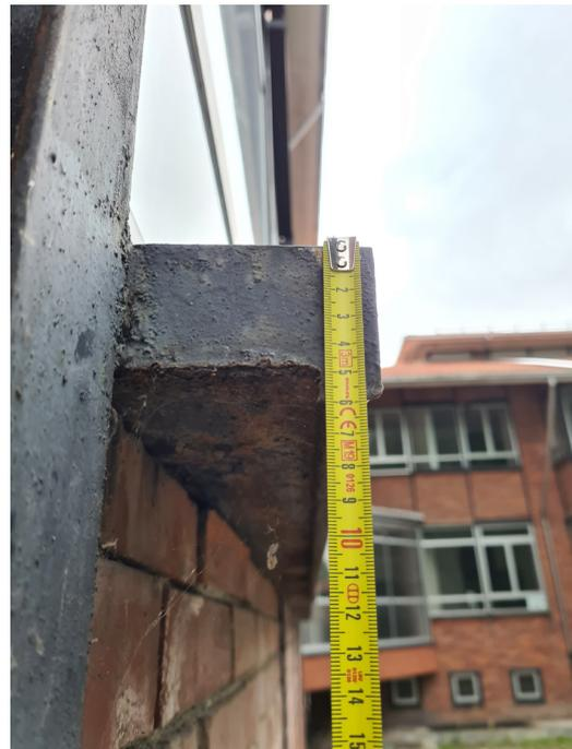
Figura 100. Dettaglio del davanzale esterno in profilato metallico scatolato in lamiera. (foto Sabrina Scala)
