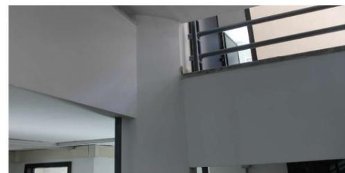
Pilastro ad angolo smussato del vano scala, in rapporto, a destra, con una trave intradossata e, a sinistra, con un muretto del parapetto
