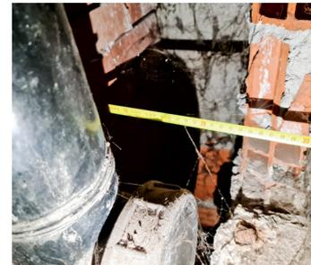
Figura 96. Stratigrafia della muratura, visionata attraverso una botola di ispezione delle tubazioni delle acque nere (foto Sabrina Scala).
