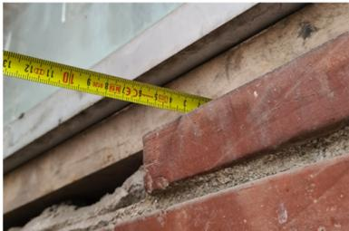
In un tratto in cui il davanzale esterno è crollato, è possibile notare come questo, posto nella parte inferiore della finestra, si inserisca direttamente in appoggio allo strato di mattoni, in continuità con quello interno.
