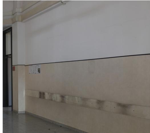
Figura 106. Attuale parete dello spazio attorno al vano scala, rifinita con intonaco rosa e bianco. (foto Sabrina Scala)
