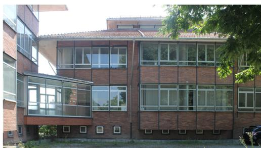
Figura 79. Stralcio del prospetto ovest del corpo avanzato, terna sud. In evidenza, diverse tipologie di infissi (foto Sabrina Scala)
