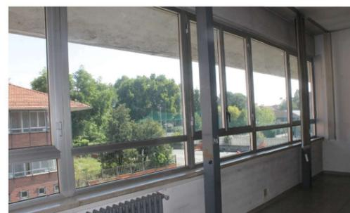
Pilastri in profili metallici a doppio "C" nell'originaria aula disegno del primo piano del corpo arretrato
