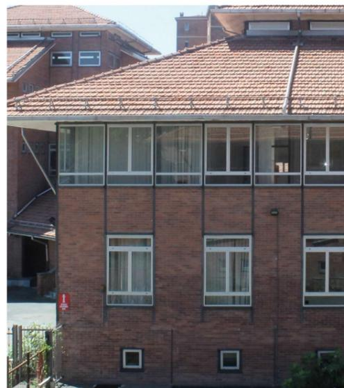
I serramenti dei corpi avanzati e arretrati: finestre rettangolari a sviluppo verticale isolate e ampie finestre e nastro, entrambe con profili metallici in collegamento orizzontale e verticale, per i piani correnti; lunghe e strette piccole finestre per il livello sottotetto.
