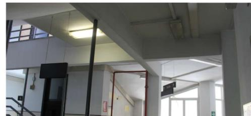
Coppia di pilastri e travi intradossate aggiunti in fase di costruzione
