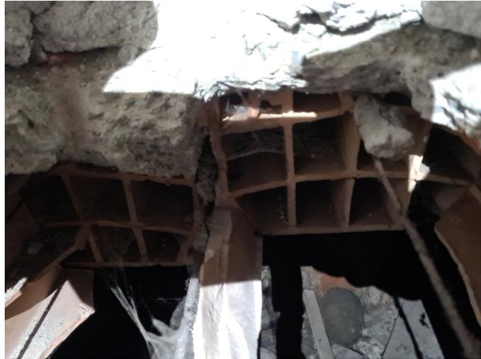
Figura 93. Stratigrafia del solaio osservata grazie ad una spaccatura nel solaio del seminterrato della galleria sud (foto Sabrina Scala).
