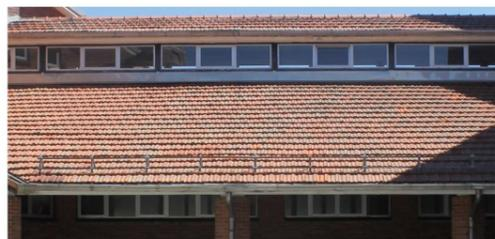
I serramenti della galleria: lunghe finestre a fascia per il livello inferiore, finestre a nastro con sviluppo orizzontale per il livello superiore.
