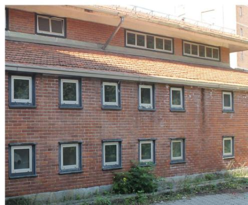
I serramenti della palestra: finestre quadrate con cornice metallica per il livello inferiore, finestre a nastro con sviluppo orizzontale per il livello superiore.
