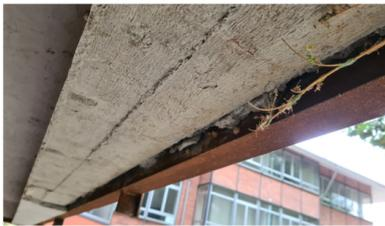
Il bow-window si conclude con una trave ribassata in c.a., rivestita inferiormente da uno strato di intonaco dello spessore di 1,5 cm e, in facciata, da uno strato di 3 cm in mattoni, sostenuti da un profilo metallico a L.
