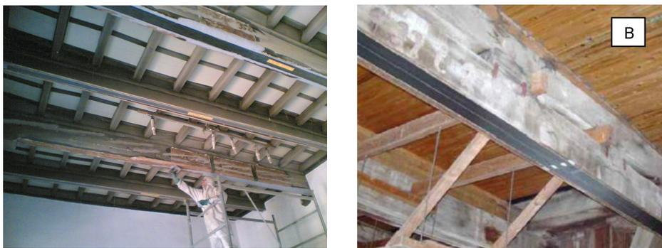
Esempi di applicazione di lamine FRP in zona tesa di travi lignee [12]
